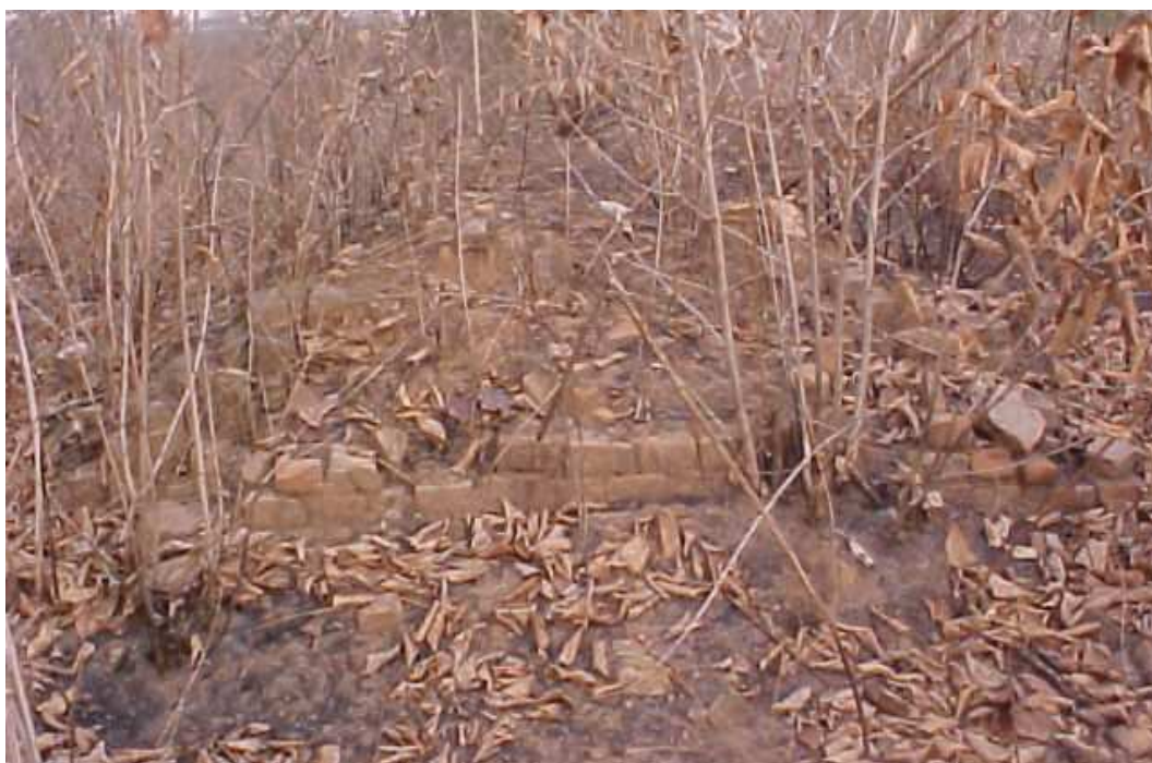
Foto 10-27 Estrutura de parede antiga igreja da Bela Vista - São Félix de Balsas – MA.
