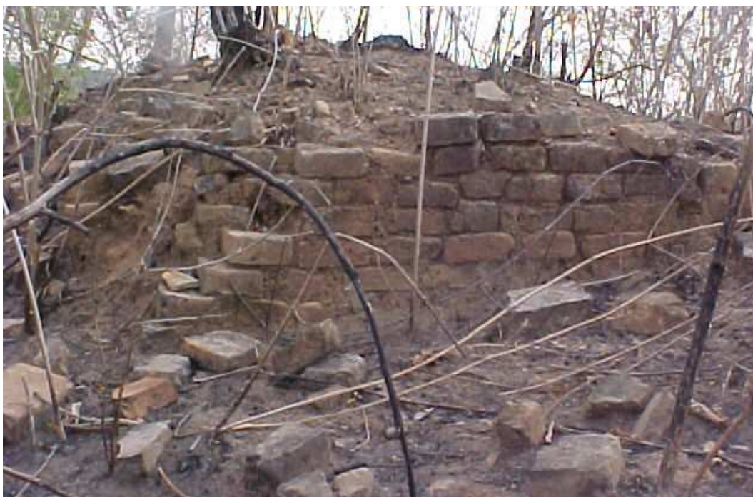
Foto 10-25 Estrutura de parede da antiga igreja da Bela Vista - São Félix de Balsas – MA.
