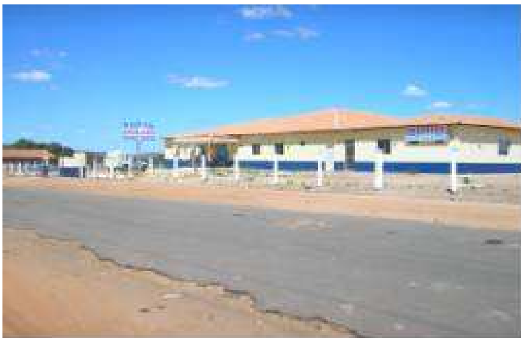
Foto 10-17 Hospital unidade de saúde da cidade de Loreto na AID do empreendimento.
