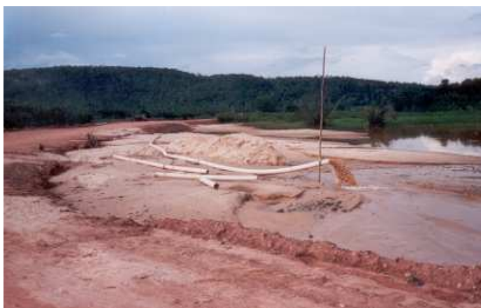
Foto 8.1-9 Dique com material de jazida e aterro hidráulico.
