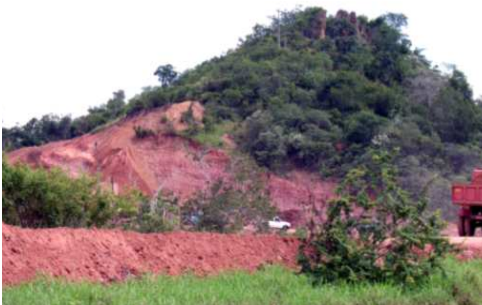
Foto 8.1-2 Vista geral construção da estrada, próximo da cidade de Uruçui, nas margens do Rio Parnaíba. Observa-se ao fundo paredão da Formação Piauí.
