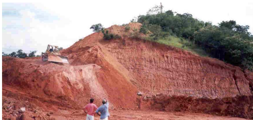
Foto 8.1-10 Panorâmica da ombreira direita.
