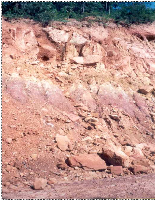
Figura 5.5-1 Mecanismo 1 - Queda de blocos por erosão diferencial no talude.
