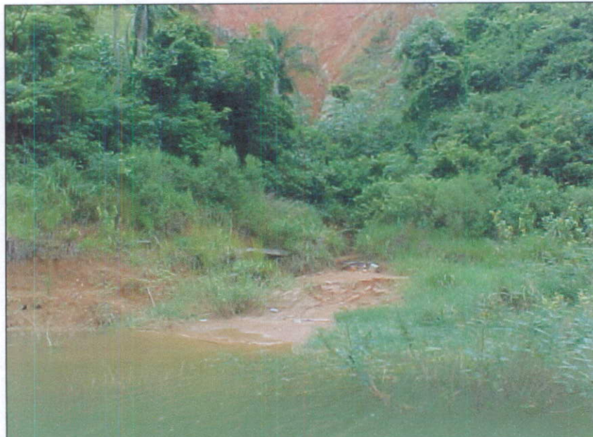
Foto 58 – Vista de uma erosão localizada na margem do reservatório em detalhe, apresentando a deposição de material proveniente do solapamento (FONTE: MRS).
