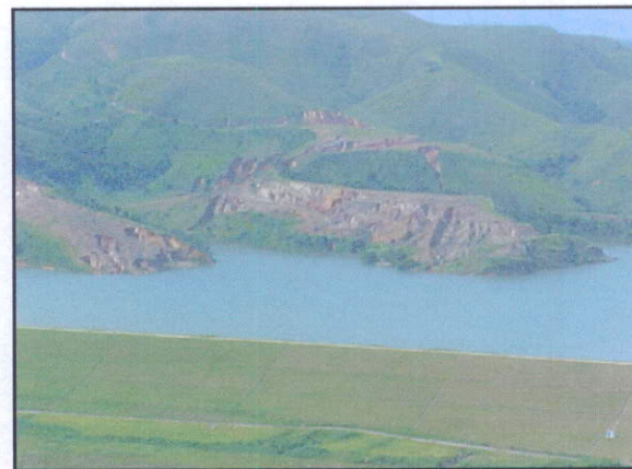
Foto 41 – Vista das erosões de Nhangapi em aproximação (FONTE: MRS).
