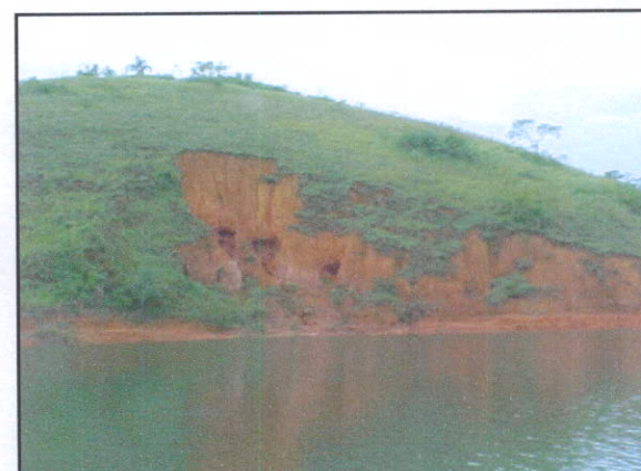
Foto 53 – Vista de erosão na margem do reservatório (FONTE: MRS).
