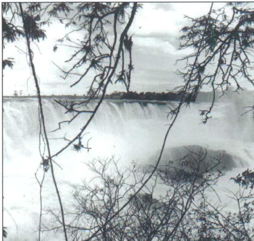
Foto 2 – Vista do Salto do Funil 1 (FONTE: FURNAS).
