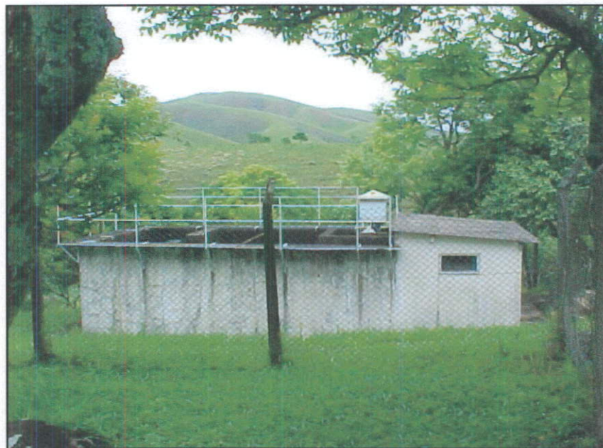
Foto 25 – Vista da Estação de Tratamento de Água – ETA da Vila Residencial (FONTE: MRS).
