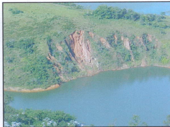
Foto 31 – Área de erosão no reservatório de Funil (FONTE: MRS).
