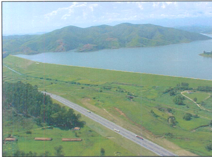
Foto 19 – Vista do Dique de Nhangapi (FONTE: MRS).
