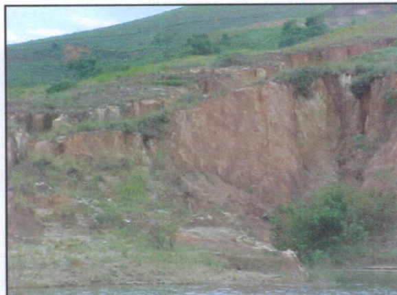
Foto 43 – Detalhe da erosão em Nhangapi (FONTE: MRS).
