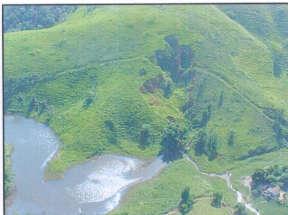
Foto 32 – Vista aérea uma erosão (FONTE: MRS)
