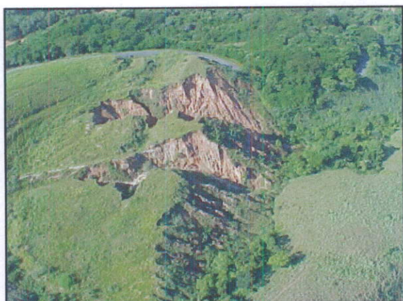
Foto 30 – Vista de erosão localizada próximo à UHE Funil (FONTE: MRS).
