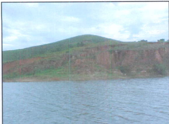
Foto 42 – Vista da erosão em frente a Nhangapi (FONTE: MRS).
