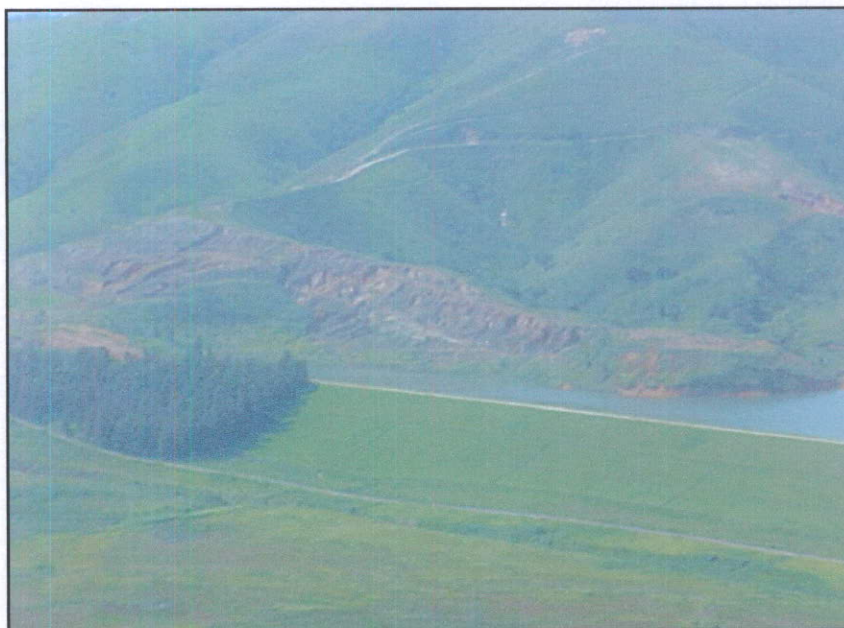
Foto 57 – Área de empréstimo da construção do Dique de Nhangapi, que resultou em erosão no local (FONTE: MRS).
