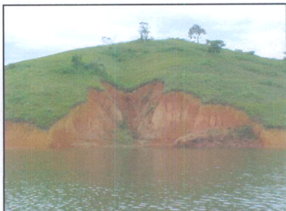
Foto 46 – Vista da erosão, sentido sul (FONTE: MRS).
