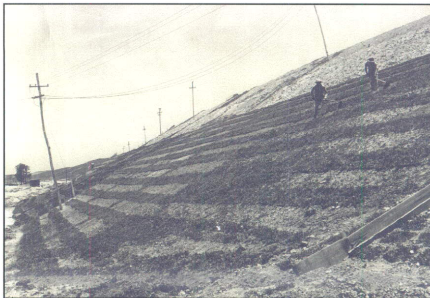
Foto 4 – Vista da construção da Barragem Auxiliar de Nhangapi (FONTE: FURNAS).
