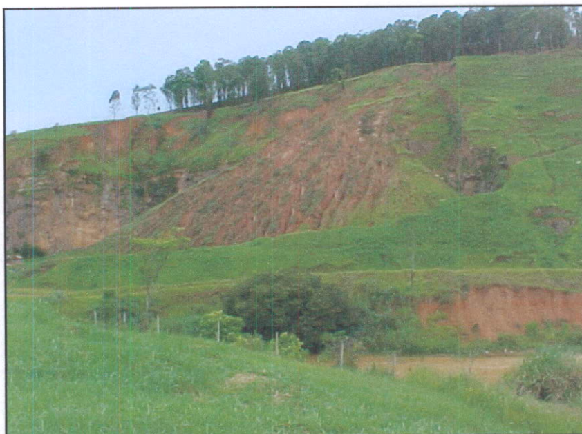
Foto 26 – Vista de erosão localizada às margens do rio Paraíba do Sul, em trecho situado ao lado da Via Presidente Dutra (FONTE: MRS).
