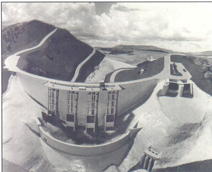
Foto 10 – Maquete da barragem (foto original em preto e branco) mostrando as torres da tomada d'água (FONTE: FURNAS).
