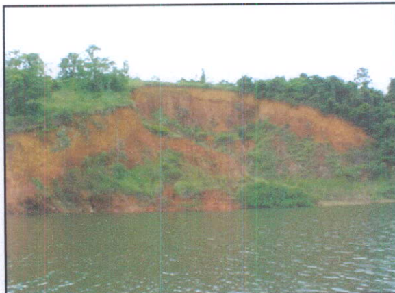
Foto 50 – Vista de uma erosão em uma ilha do reservatório (FONTE: MRS).
