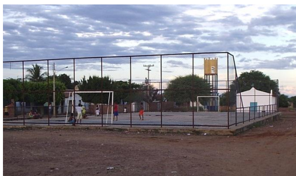
Figura 3.5 Equipamento comunitário (quadra de esporte, Igreja e caixa d'água) - Inhanhum (PE)
