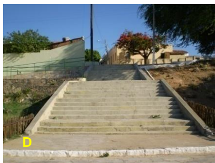
D Cais. Escadaria principal – antigo ancoradouro da cidade – ligação com a Travessa Nunes Machado
