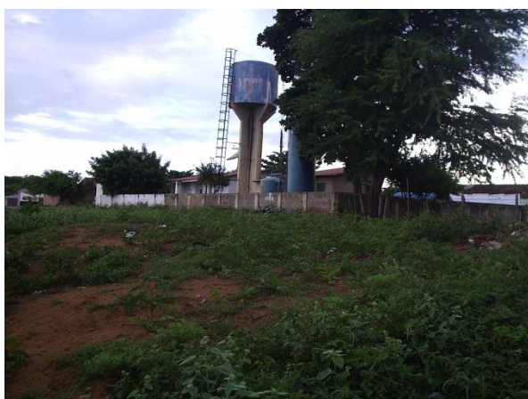
Figura 3.13 Estrutura do SAAE que abastece o povoado de Riacho Seco (BA)
