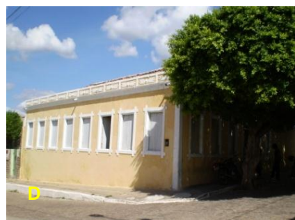
D Casas nº 36/49 (numeração pela Travessa Nunes Machado). Esta casa possui a maior quantidade de janelas (oito laterais e cinco na frente). Está localizada da Rua Nunes Machado e foi construída pelo Cel. Florêncio Alves de Barros, casado em primeiras núpcias com Lucilla de Freitas Sampaio
