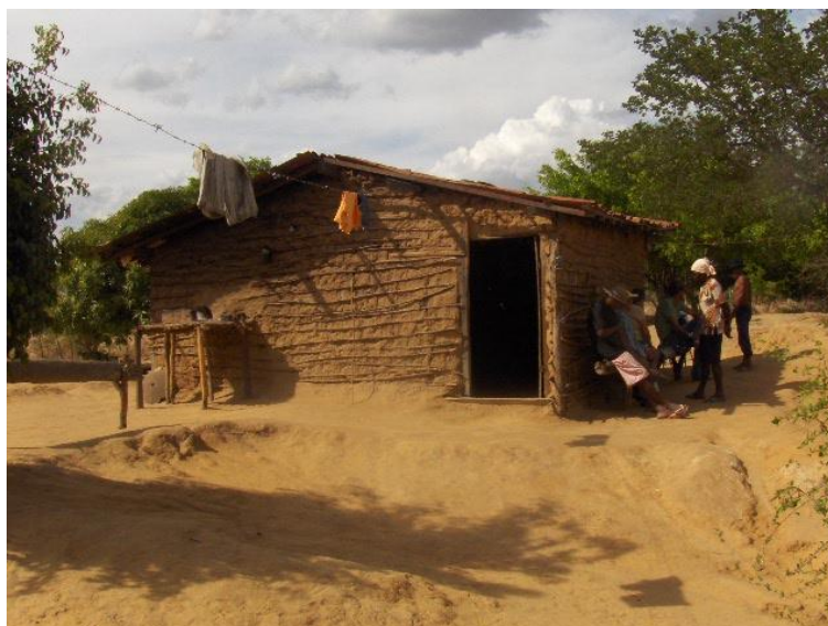
Figura 4.28 PA Bom Sossego – casas de taipa ocupadas na beira rio, Santa Maria da Boa Vista (PE)
