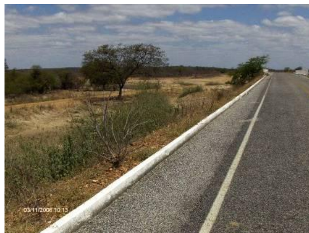
Figura 1.64 PE-574 – Aspectos de conservação
