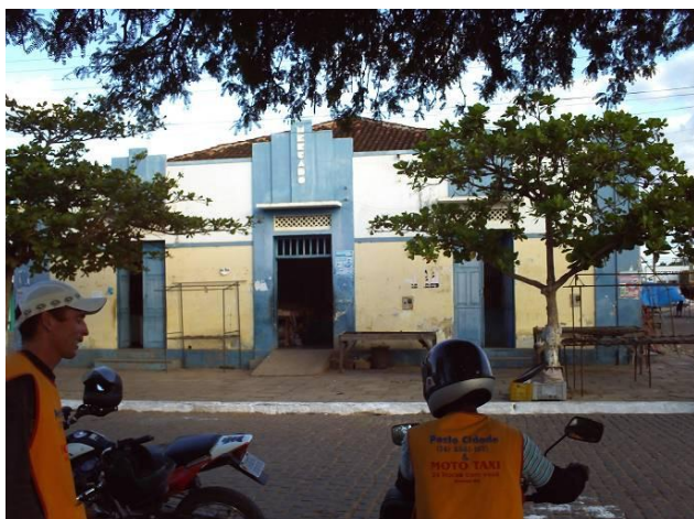
Figura 1.41 Vista da entrada do mercado
