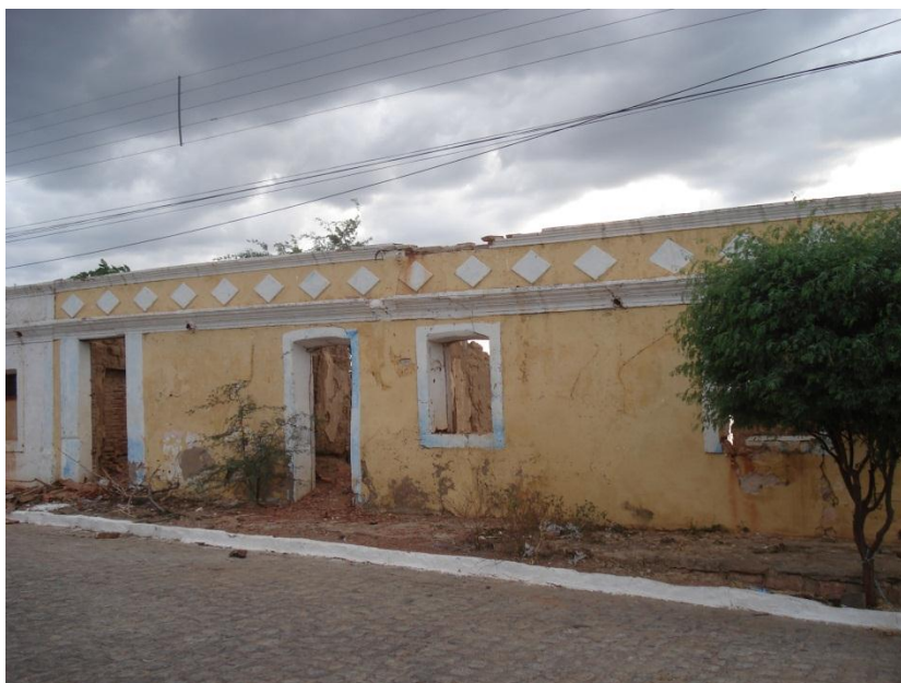
Figura 7.1 Fachada frontal da Fazenda da Volta localizada na área urbana de Santa Maria da Boa Vista – PE
