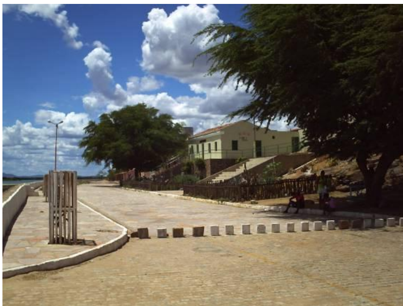
Figura 1.17 Vista do cais / Pátio de eventos e do Museu Coripós
