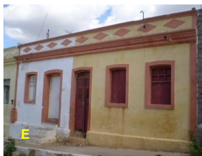
E Casa 227. Encontra-se hoje “desmembrada” em dois imóveis. A de cor amarela apresenta apenas a fachada frontal, como foi possível constatar no levantamento de campo
