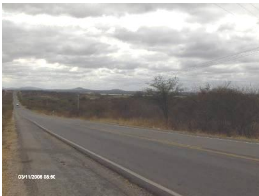
Figura 1.62 BR-428 - Trecho Santa Maria da Boa Vista – Lagoa Grande (PE)
