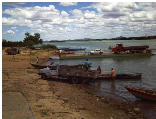
Figura 1.16 Vista do Píer de atracação da balsa
