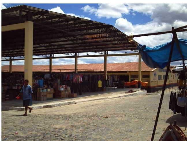
Figura 1.13 Vista do galpão da feira
