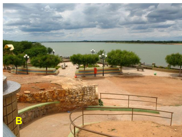
Figura 2.19 A e B Orla fluvial - Cais urbanizado em diferentes níveis, de forma a superar a diferença de altura entre o rio e a cidade
