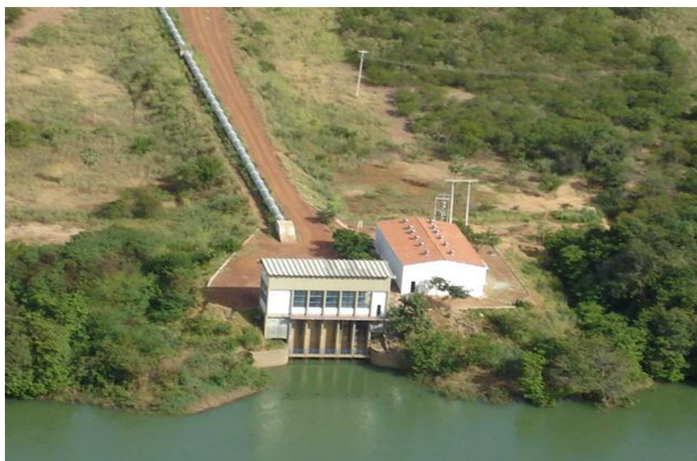
Figura 2.52 Estação de Bombeamento – EB1 do Projeto de Assentamento Curaçá (BA)
