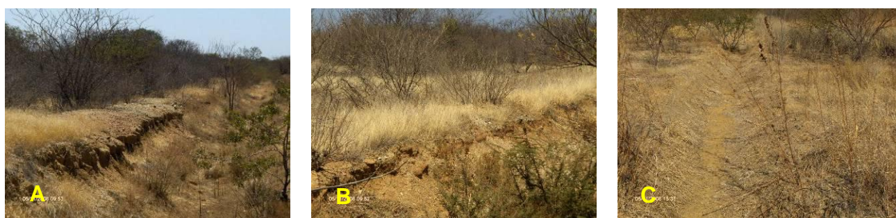
Figura 2.30 A, B e C Canal de drenagem em propriedade rural localizada em Curaçá (BA)
