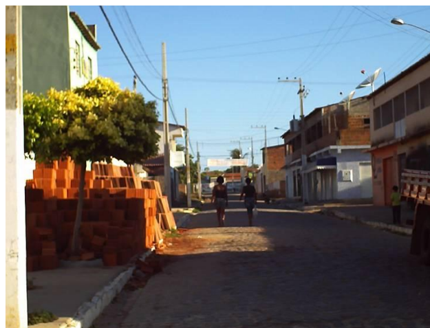
Figura 1.23 Vista do Setor 4, com edificações de 2 pavimentos
