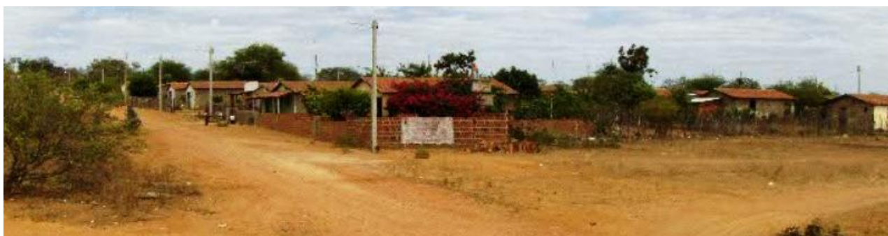
Figura 4.12 PA Nossa Senhora da Conceição - Vista panorâmica parcial da vila II integrada à comunidade Nova Olinda, Santa Maria da Boa Vista (PE)
