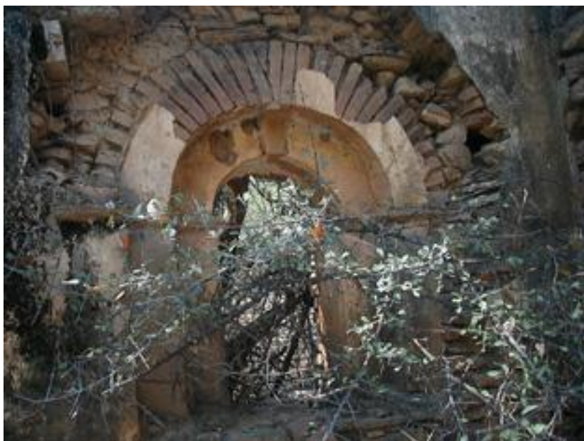
Figura 7.6 Detalhe do arco em tijolo e parte do reboco ainda preservado no interior Igreja da Ilha da Missão em Santa Maria da Boa Vista - PE
