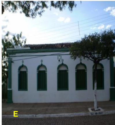
E Casa da Praça do Bom Jesus, ao lado do rio. Destaque para as aberturas em arcos (de influência ou interpretação popular do arco ogival ou manuelino)
