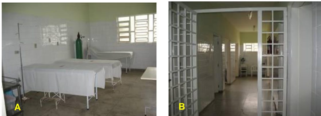
Figura 2.78 A e B Hospital de Curaçá: área de circulação, à direita, e enfermaria, à esquerda
