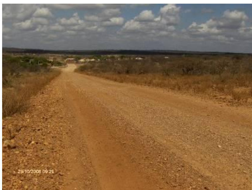
Figura 1.65 Estrada municipal que interliga os povoados de Cupira e Inhanhum ao município de Santa Maria da Boa Vista - Ao fundo vista do Povoado de Cupira – Santa Maria da Boa Vista (PE)
