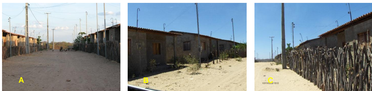
Figura 4.27 A, B e C PA Bom Sossego – Vista da vila. Instalação de energia elétrica paralisada por motivo de roubos da fiação, Santa Maria da Boa Vista (PE)
