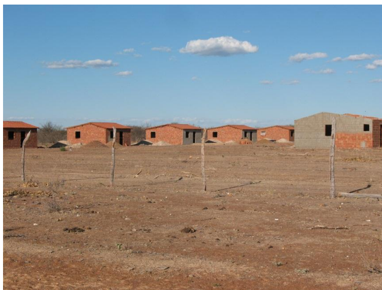
Figura 4.30 PA Nova Esperança – vila em construção, Santa Maria da Boa Vista (PE)
