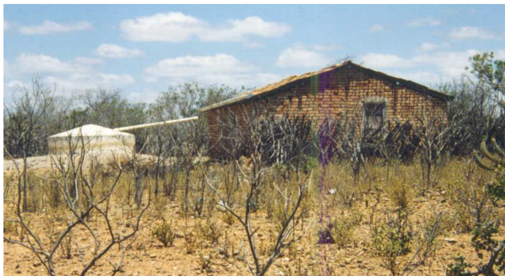
Figura 4.1 Sistema de captação de águas de chuva a partir de calhas e tubulação
