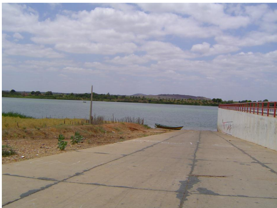
Figura 2.3 Rampa colúvio-aluvionar na localidade de Vermelhos - PE
