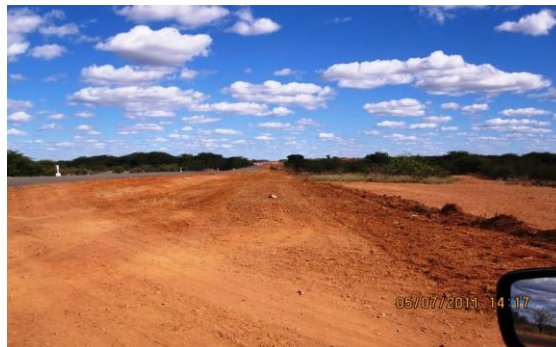
Figura 1.25 Rodovia BA-210 que dá acesso a cidade de Curaçá - Ponto G
