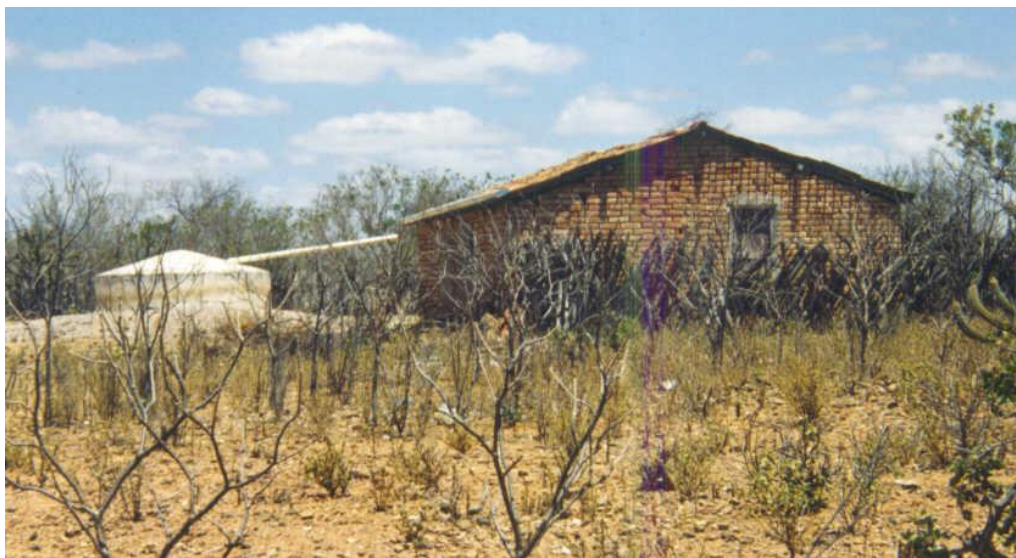
Figura 1.3 Sistema de captação de águas de chuva a partir de calhas e tubulação
