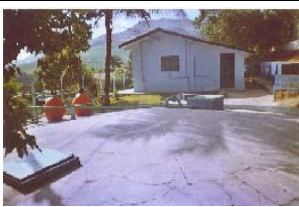
FOTO 06 - Reservatório enterrado de água tratada. Vide filtros de areia sobre o reservatório e laboratório ao fundo. Adrianópolis - PR.
