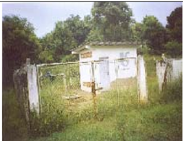
FOTO 02 – Captação de água para abastecimento público poço profundo sede Itapirapuã Paulista- SP.
