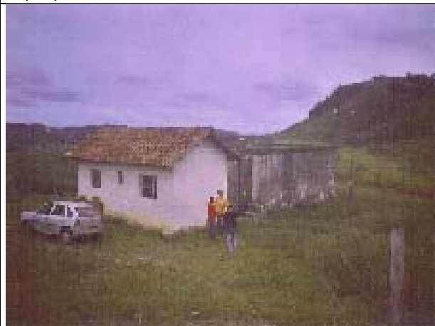
FOTO 03 – Reservatório de água tratada e casa de tratamento sede Dr. Ulysses- PR.
