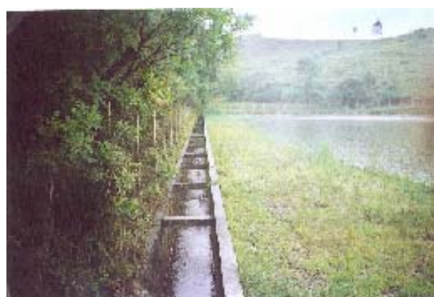
FOTO 15 - Detalhe de canal de liberação de água processada. Lagoa tratamento Itapirapuã Paulista-SP
