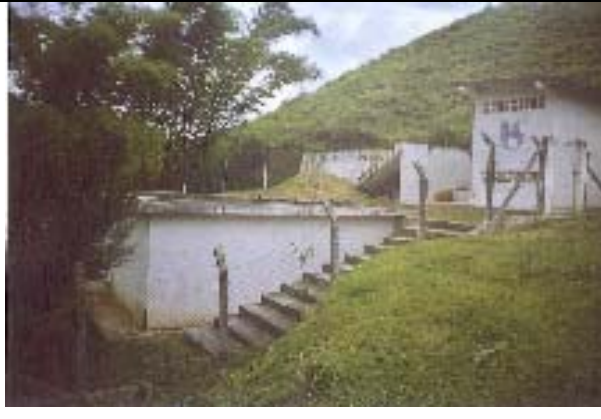
FOTO 18 - Local de reservação e tratamento de água do córrego Panelinhas, abastecimento bairro Catas Altas e outros. Ribeira-SP.
