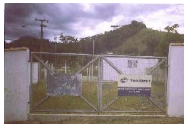
FOTO 23 - ETE Vila Eliane sede Cerro Azul-PR
