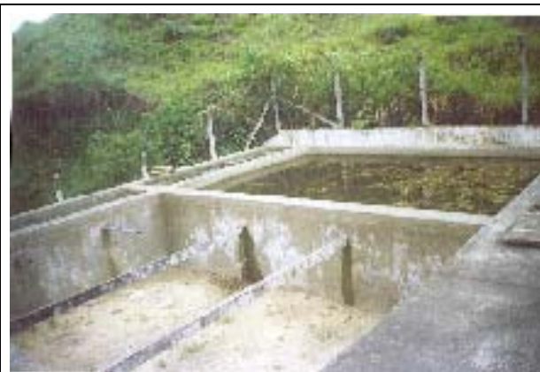
FOTO 19 - Tanques de floculação e decantação do local de tratamento (inativos) da captação de água para abastecimento público do córrego Panelinhas, Ribeira-SP.
