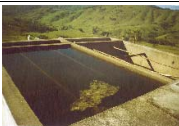
FOTO 20 - Tanque de decantação da captação de água para abastecimento público do bairro de Saltinho, Ribeira-SP. ETA em reforma.
