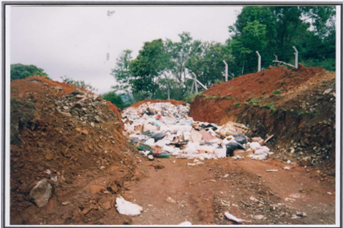
FOTO 7. Primeira vala em operação, com lixo sem recobrimento.
