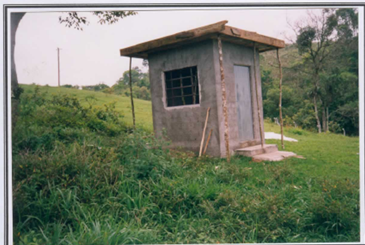
FOTO 6. Execução parcial da guarita do aterro sanitário.
