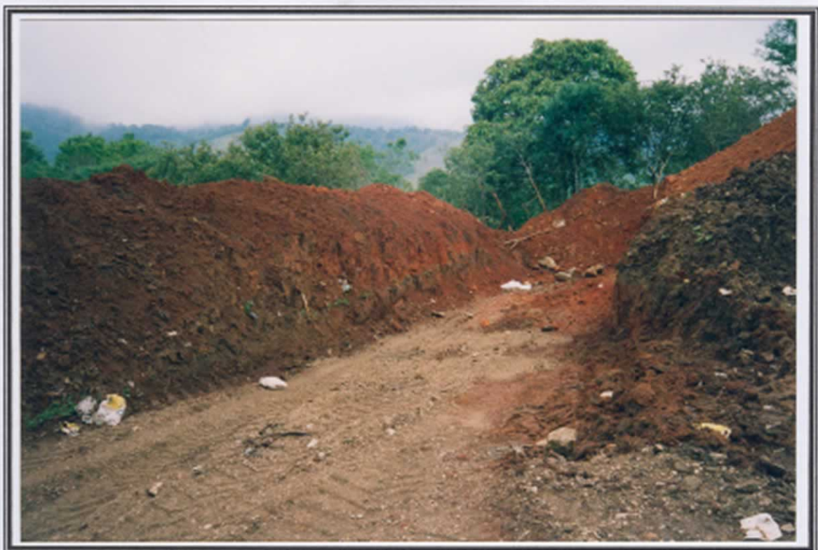
FOTO 8. Segunda vala aberta sem operação.
