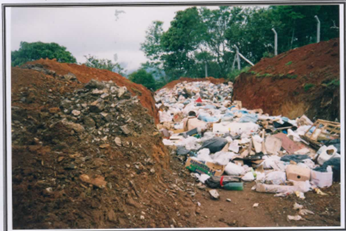
FOTO 9. Primeira vala em operação, com lixo sem recobrimento.
