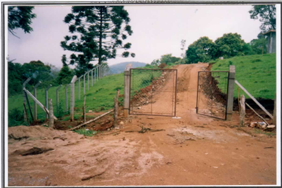
FOTO 1. Portão metálico de acesso ao aterro sanitário de Ribeira.
