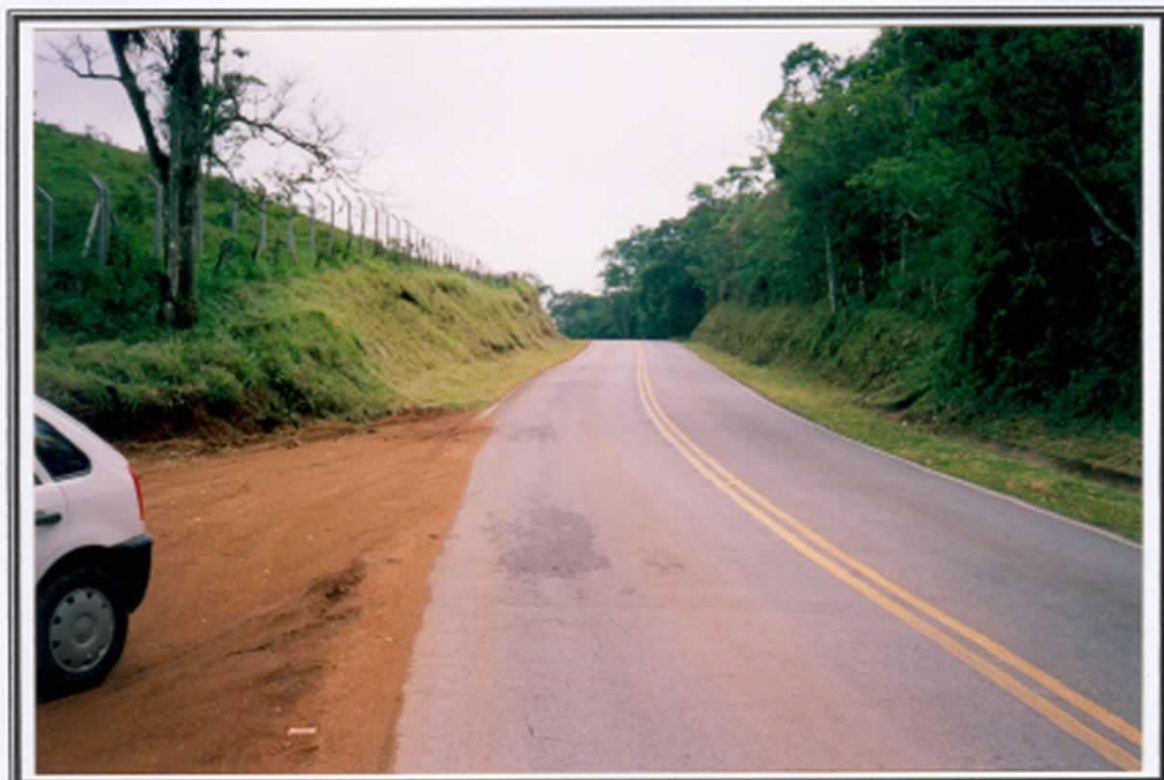
FOTO 2. Estrada de acesso ao aterro sanitário, pavimentada.
