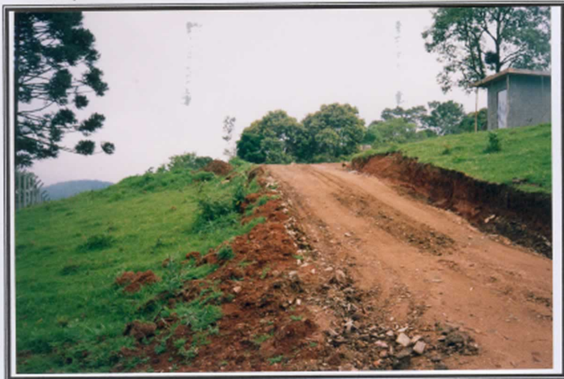
FOTO 5. Acesso interno implantado.
