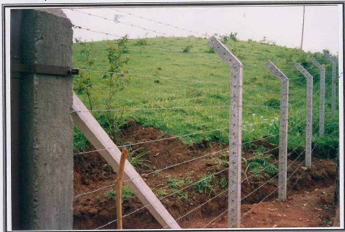
FOTO 3. Cerca executada com mourão de concreto e arame farpado ( 11 fios).
