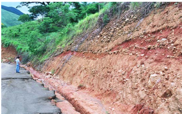
FOTO 54 - Ponto 30A UTM 703.048 mE x 7.268.525 mN - 237 m: pormenor da base do depósito rudáceo, ilustrado na foto 53, mostrando blocos de quartzo e metassedimentos imersos em matriz avermelhada e variegada, argilo arenosa, muito coesa, com grãos e fragmentos esparsos de quartzo.
