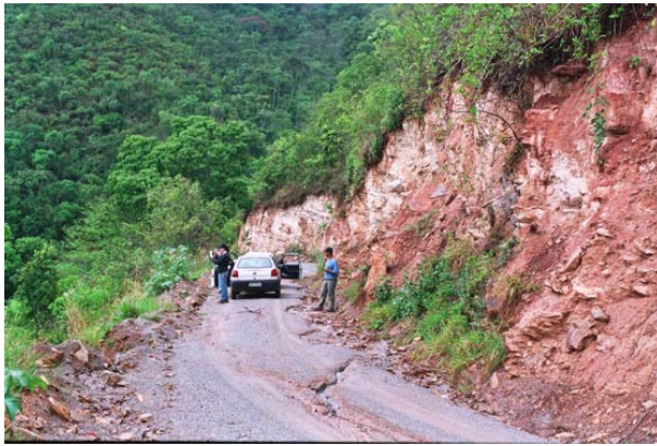
FOTO 42 - Ponto 91 UTM 698.46 mE x 7.271.570 mN - 191 m: alto talude escavado em calcário marmóreo cinza esverdeado claro, com nítida foliação na direção N80°; 70°NW.
