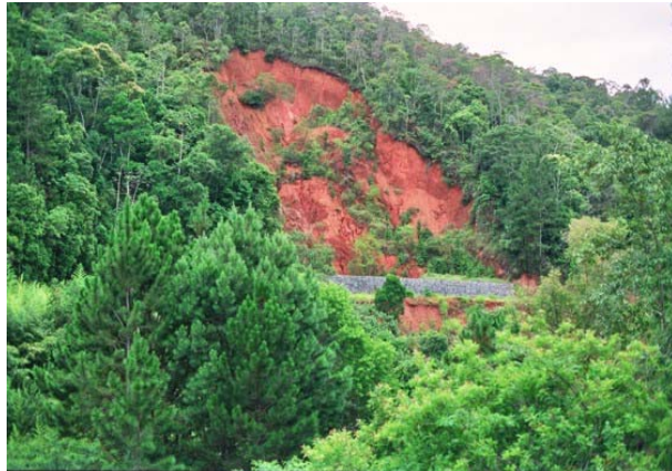
FOTO 13 - Ponto 9A UTM 710.035 x 7.283.843 mN -738 m: movimento de massa em encosta íngreme da rodovia Apiaí-Ribeira, onde ocorrem grandes espessuras de solos de alteração de rochas graníticas grossas, com grande suscetibilidade a erosão no horizonte C.
