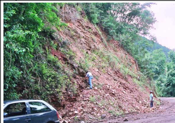
FOTO 20 - Ponto 26A UTM 701.515 mE x 7.267.066 mN - 332 m: movimento de massa em talude escavado em rochas metapelíticas alteradas, desencadeado ao longo de descontinuidades de fratura, sendo que a foliação mergulha para o interior do talude; a foliação tem direção N90°E; 30°S.
