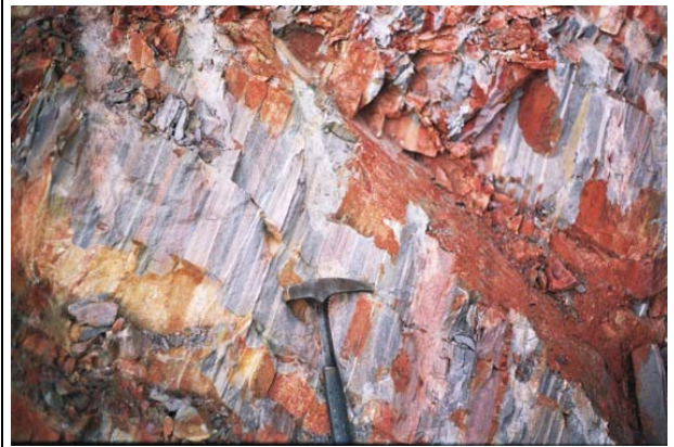
FOTO 20 - Ponto 26A UTM 701.515 mE x 7.267.066 mN - 332 m: movimento de massa em talude escavado em rochas metapelíticas alteradas, desencadeado ao longo de descontinuidades de fratura, sendo que a foliação mergulha para o interior do talude; a foliação tem direção N90°E; 30°S.
