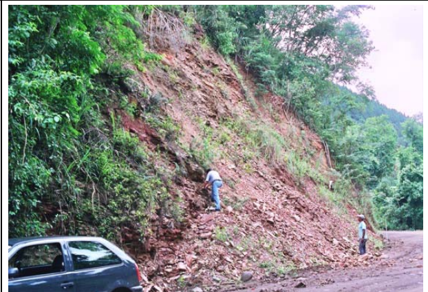
FOTO 20 - Ponto 26A UTM 701.515 mE x 7.267.066 mN - 332 m: movimento de massa em talude escavado em rochas metapelíticas alteradas, desencadeado ao longo de descontinuidades de fratura, sendo que a foliação mergulha para o interior do talude; a foliação tem direção N90°E; 30°S.
