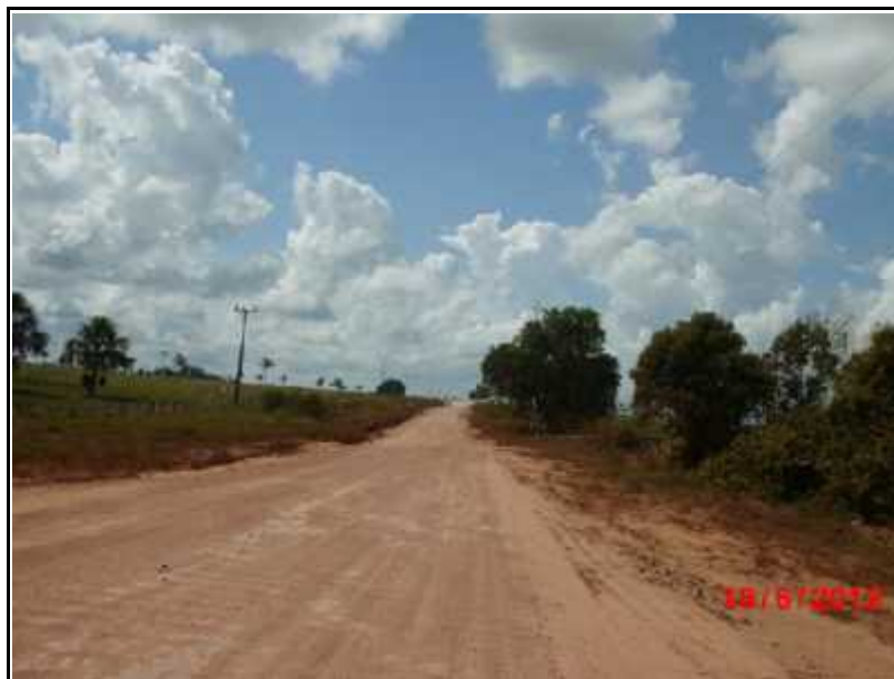
FIGURA 1 – Estrada de acesso à UHE Teles Pires.
