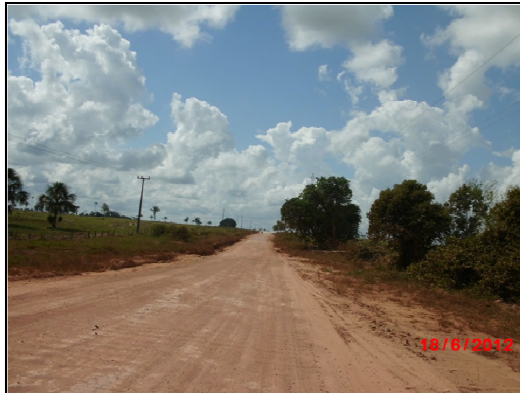
FIGURA 1 – Estrada de acesso à UHE Teles Pires.
