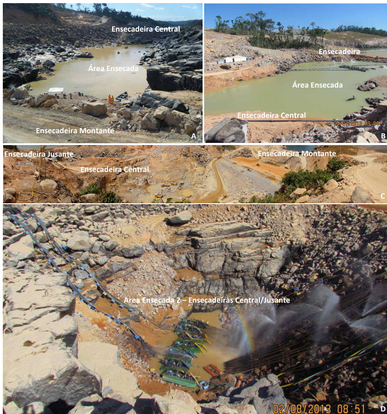
Prancha 02. Ensecadeiras de desvio do rio Teles Pires trechos ensecados 1 e 2: (A) Trecho Ensecado 01 - Ensecadeira de Montante/Central; (B) Trecho Ensecado 02 - Ensecadeira de Central/Jusante; (C) visão panorâmica da área total ensecada em agosto 2013 e (D) Detalhe da área ensecada 2 – ensecadeiras de central/jusante praticamente drenada completamente.
