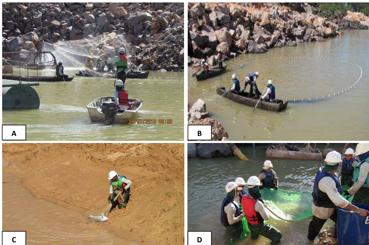
Prancha 07 – Petrechos de pesca utilizados para resgate na ensecadeira de desvio do rio Teles Pires, junho/julho/agosto 2013 – UHE Teles Pires: (A) utilização de tarrafas; (B) ) arrasto de fundo; (C) detalhe peixe resgatado com tarrafa e (D) arrastos de tela mosqueteira.
