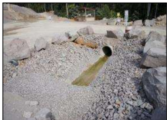
Lançamento de enrocamento rochoso para retenção de sedimentos das centrais.
