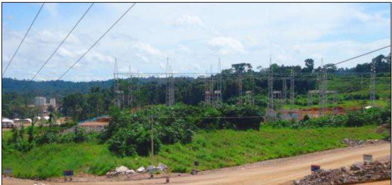
Vista Panorâmica da região da Oficina Volante em Processo de Recuperação – Abril de 2014.
