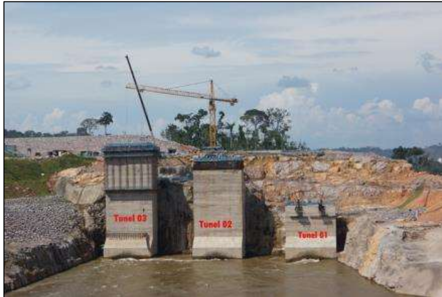
Emboque – Finalização dos túneis de desvio.
