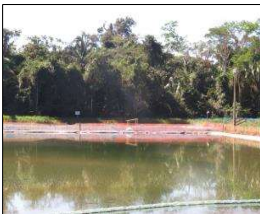
Estação de Tratamento de Esgoto 01.
