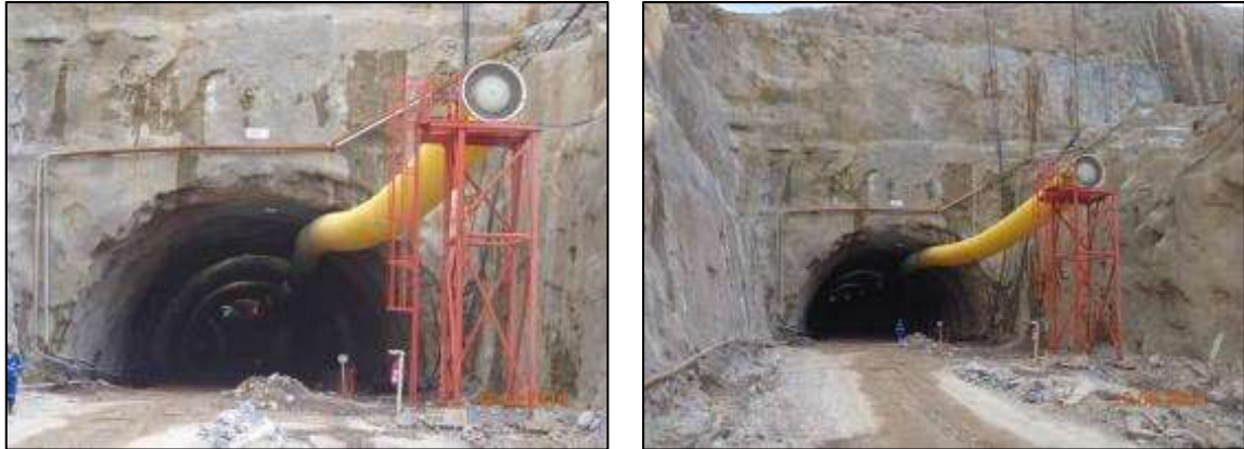
Instalação de sistema de exaustão nos túneis de desvio.
