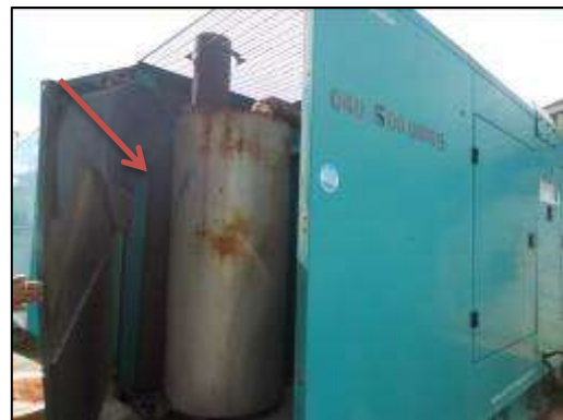
Internamente na estrutura do gerador está instalado silencioso com isolamento. Ex.: Saída do motor, silencioso e escapamento.
