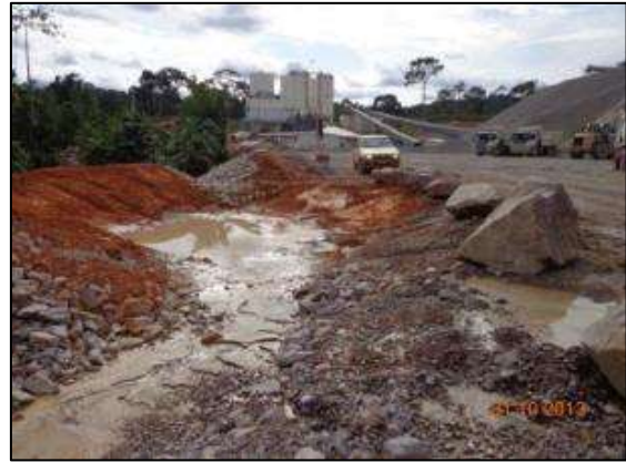
Implantação de bacias dissipação a fim de conter sedimento oriundo das frentes de serviço.
