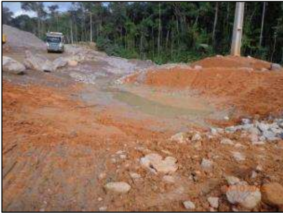
Implantação de bacias dissipação a fim de conter sedimento oriundo das frentes de serviço.
