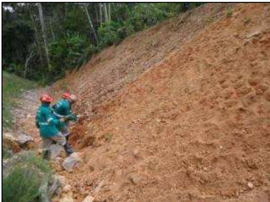
Escarificação de talude de corte em acesso provisório.
