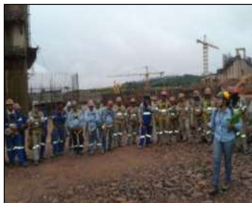
TDT com a equipe das obras do Vertedouro
