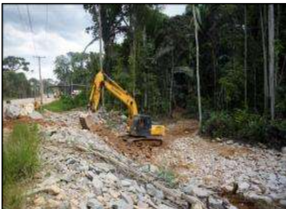
Ações de controle de processos erosivos com lançamento de enrocamento rochoso em taludes.
