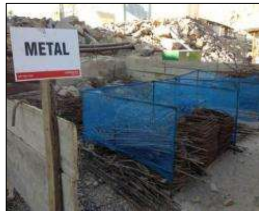
Boa prática – Reflexo dos treinamentos, instalação de baias para triagem e reuso de sucata metálica e madeira da construção civil na Casa de Força.
