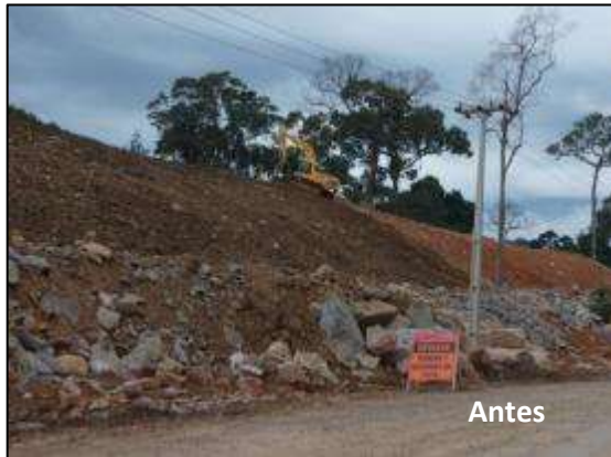
Controle de estabilização de taludes com lançamento de material vegetal e plantio de leguminosas.
