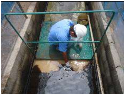
Limpeza e manutenção das Caixas SAO além do recolhimento por empresa licenciada.
