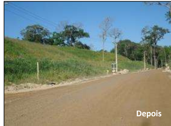
Controle de estabilização de taludes com lançamento de material vegetal e plantio de leguminosas.
