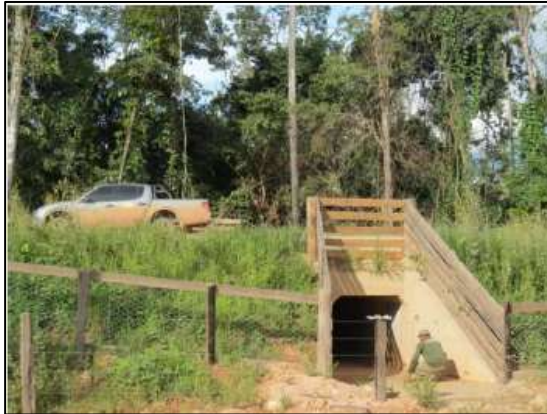
Monitoramento e manutenção das passagens de fauna no acesso definitivo.
