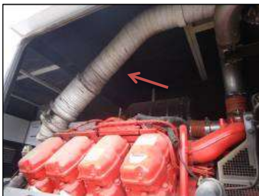
Internamente na estrutura do gerador está instalado silencioso com isolamento. Ex.: Saída do motor, silencioso e escapamento.
