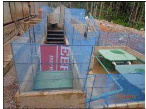
Rampa de lavagem com sistema de drenagem interligado ao Sistema SAO.
