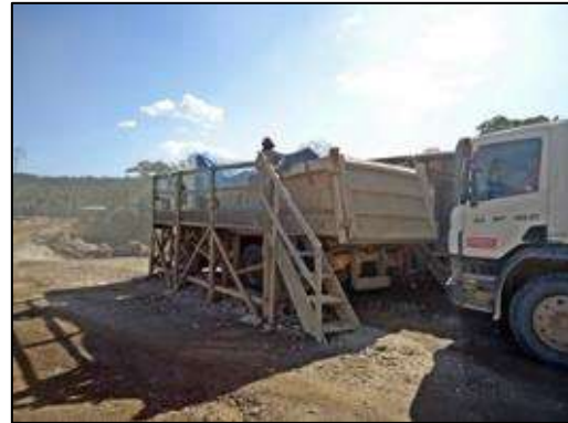
Escada e passarela para acoplamento de lona a fim de evitar ação do vento sobre material solto nos caminhões que trafegam no acesso interno do canteiro
