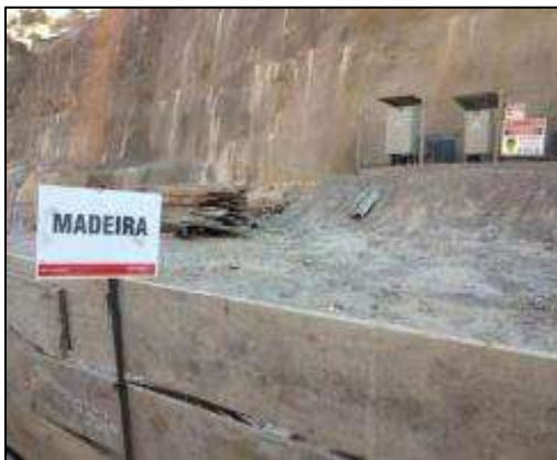
Boa prática – Reflexo dos treinamentos, instalação de baias para triagem e reuso de sucata metálica e madeira da construção civil na Casa de Força.
