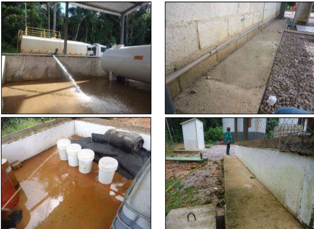
Atividade de teste de estanqueidade baia de contenção - Plante de Combustível.
