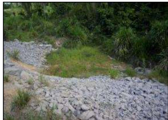
Ações de controle de processos erosivos com lançamento de enrocamento rochoso em taludes.
