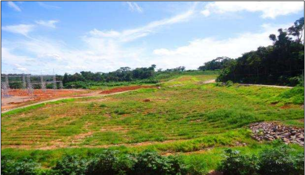
Vista Panorâmica do Bota-Fora a Jusante da Subestação da Margem Direita em Processo de Recuperação – Abril de 2014.
