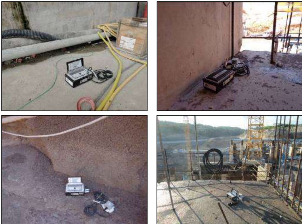
Monitoramento de ruído no âmbito do canteiro de obras
