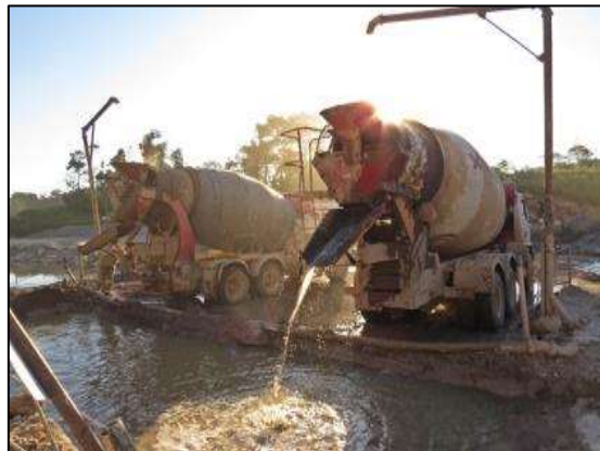
Reuso de água na lavagem de caminhões betoneira.
