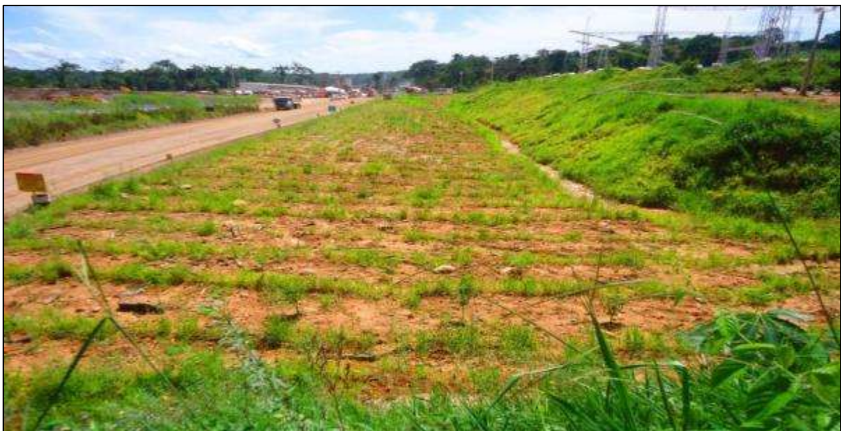
Vista Panorâmica da área a Montante da Subestação da Margem Direita em Processo de Recuperação Abril de 2014.
