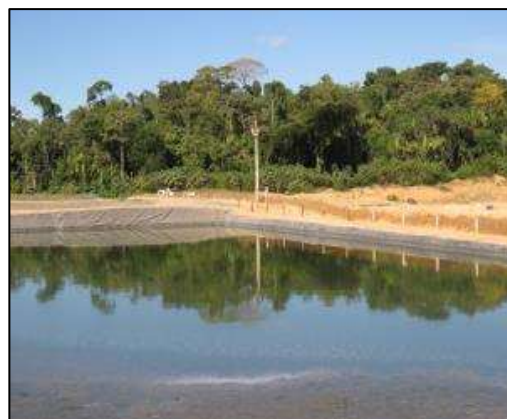
Estação de Tratamento de Esgoto 02.
