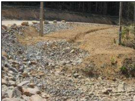
Canal, escada rochosa e bacia de retenção, bueiro com escada rochosa.
