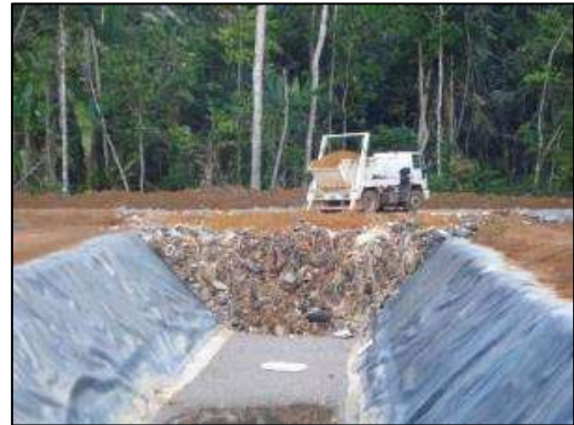
Central de Gerenciamento de Resíduos com a disposição de resíduos na célula do aterro.
