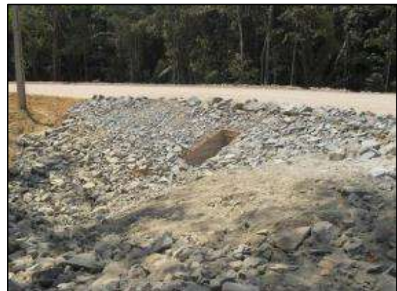
Canal, escada rochosa e bacia de retenção, bueiro com escada rochosa.
