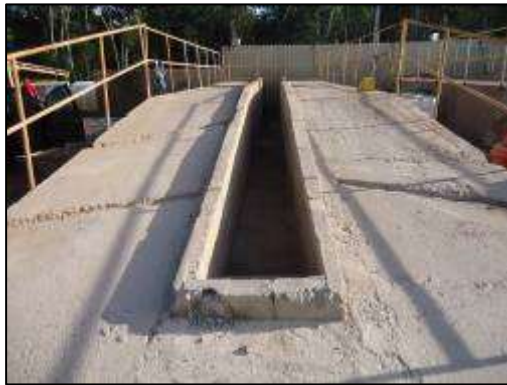
Rampa de lavagem com sistema de drenagem interligado ao Sistema SAO.
