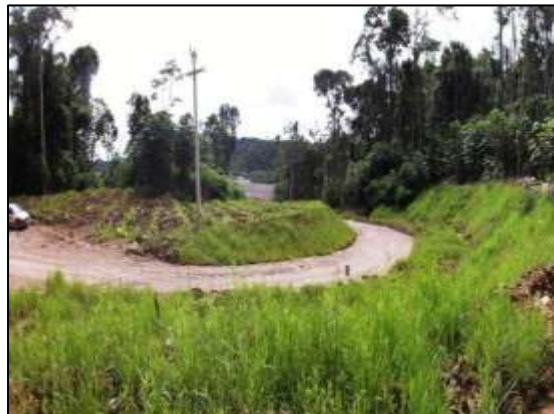
Área da oficina de terceiros da Margem Esquerda após a intervenção, em Fevereiro de 2014.
