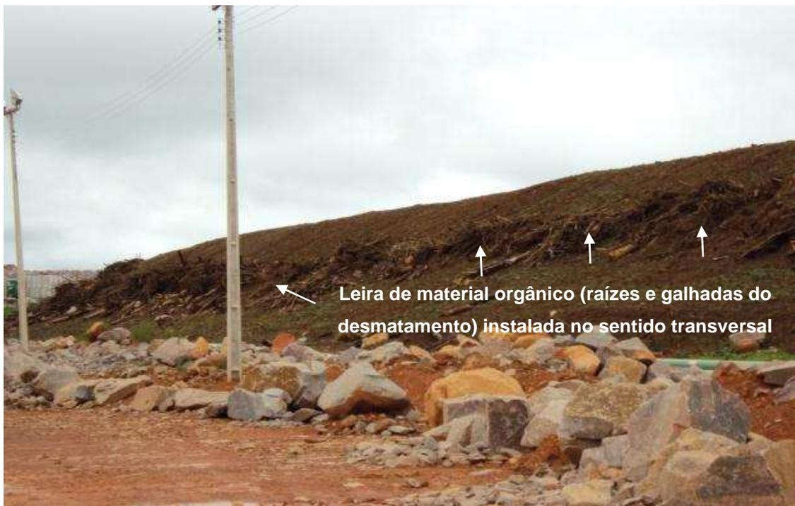
Figura nº 12. Exemplo de retentor orgânico natural instalado na superfície do talude de aterro do bota fora. Fonte: talude de aterro do bota fora 01 – ME – UHE Santo Antônio-Porto Velho – RO.
