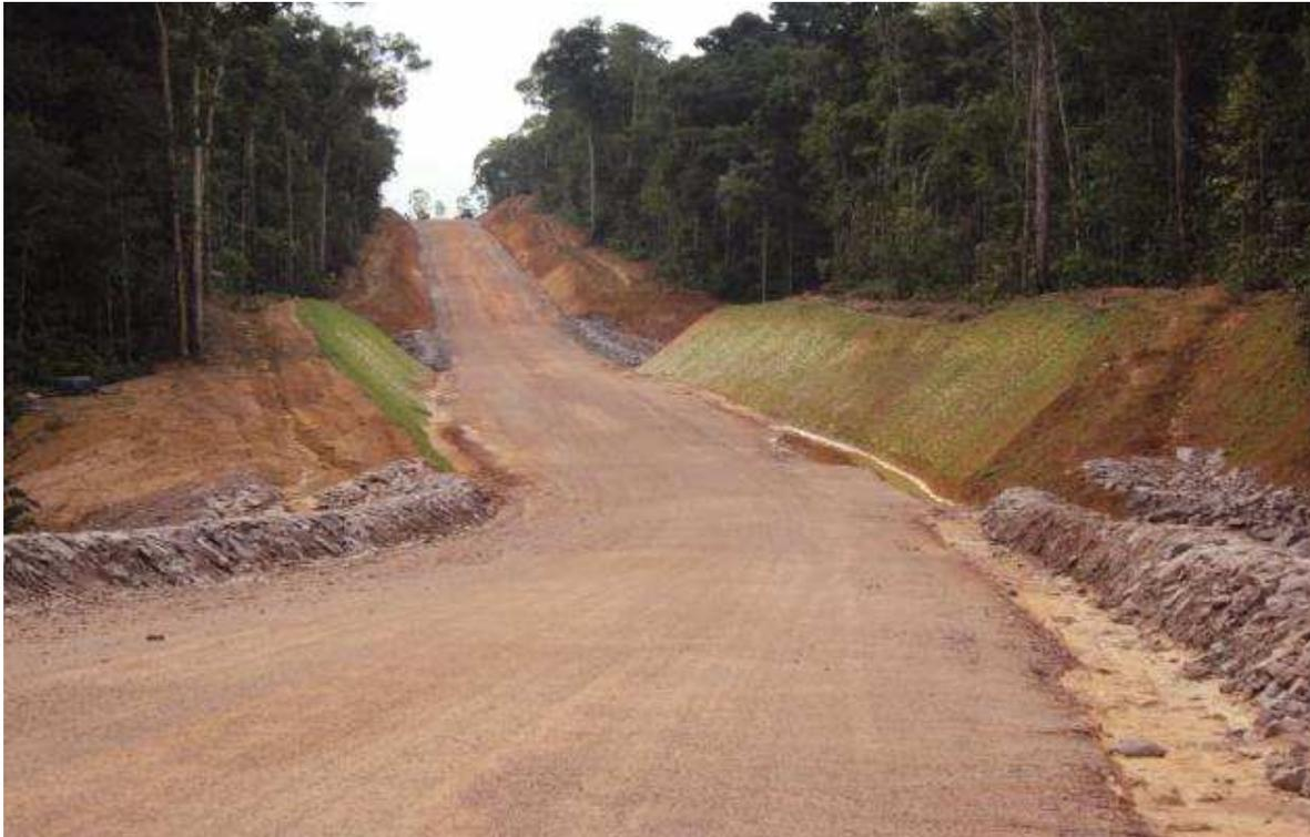
**Figura 15: Exemplo de instalação de proteção de crista no aterro do acesso, conformação de drenagem e plantio de taludes. Fonte: Acesso AMD 08 – UHE Santo Antônio – RO:**
