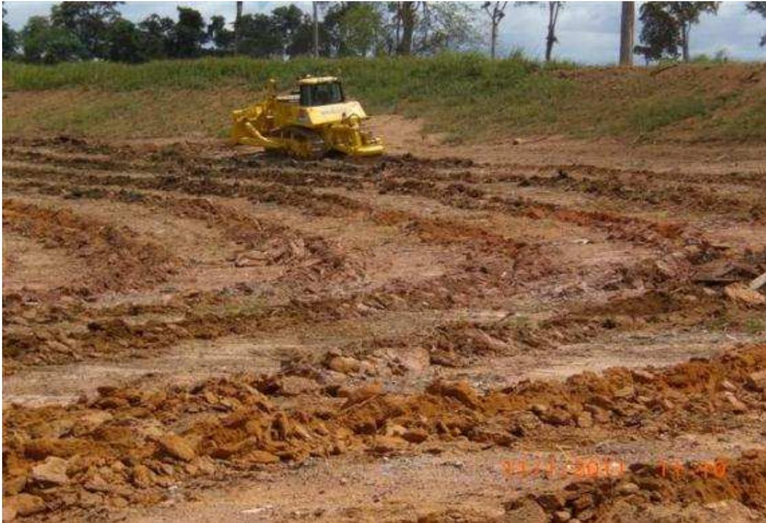
Figura nº 05. Exemplo de abertura de sulcos em nível na superfície do terreno. Sulco aberto numa profundidade de 0,60 m com trator de esteira equipado com ripper.
