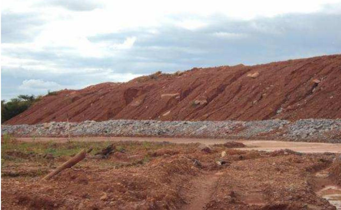
Figura nº 09. Cordão de rocha instalado nos limites do bota fora de solo para conter dispersão de sólidos durante o processo de lançamento de material, mostrando talude ainda não conformado.
