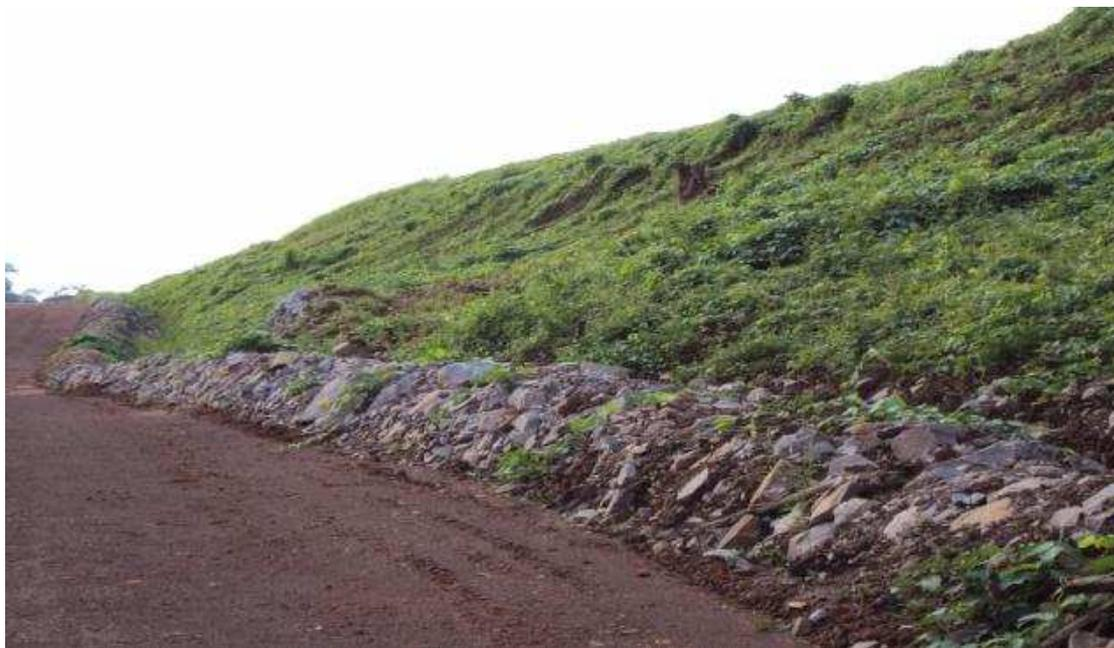
Figura nº 10. Reconformação da superfície do talude, lançamento de camada de solo vegetal e plantio de forrageiras *Fonte: Bota fora 2 (solo) – UHE Santo Antônio – Porto Velho-RO – 10/04/2010.*
