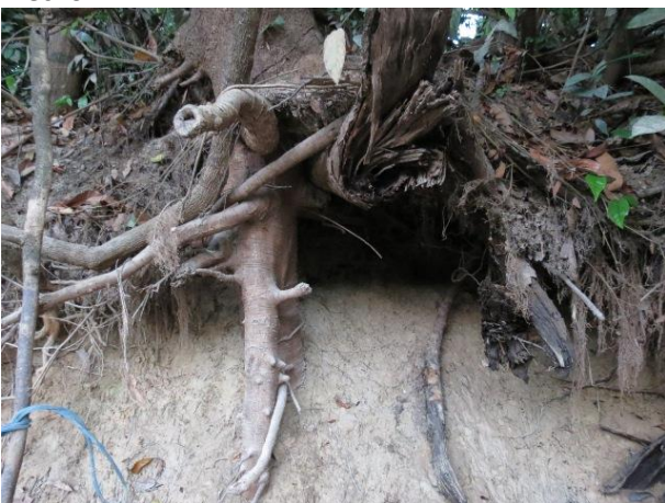
Figura 27. Loca construída sob raiz no Trecho 3.
