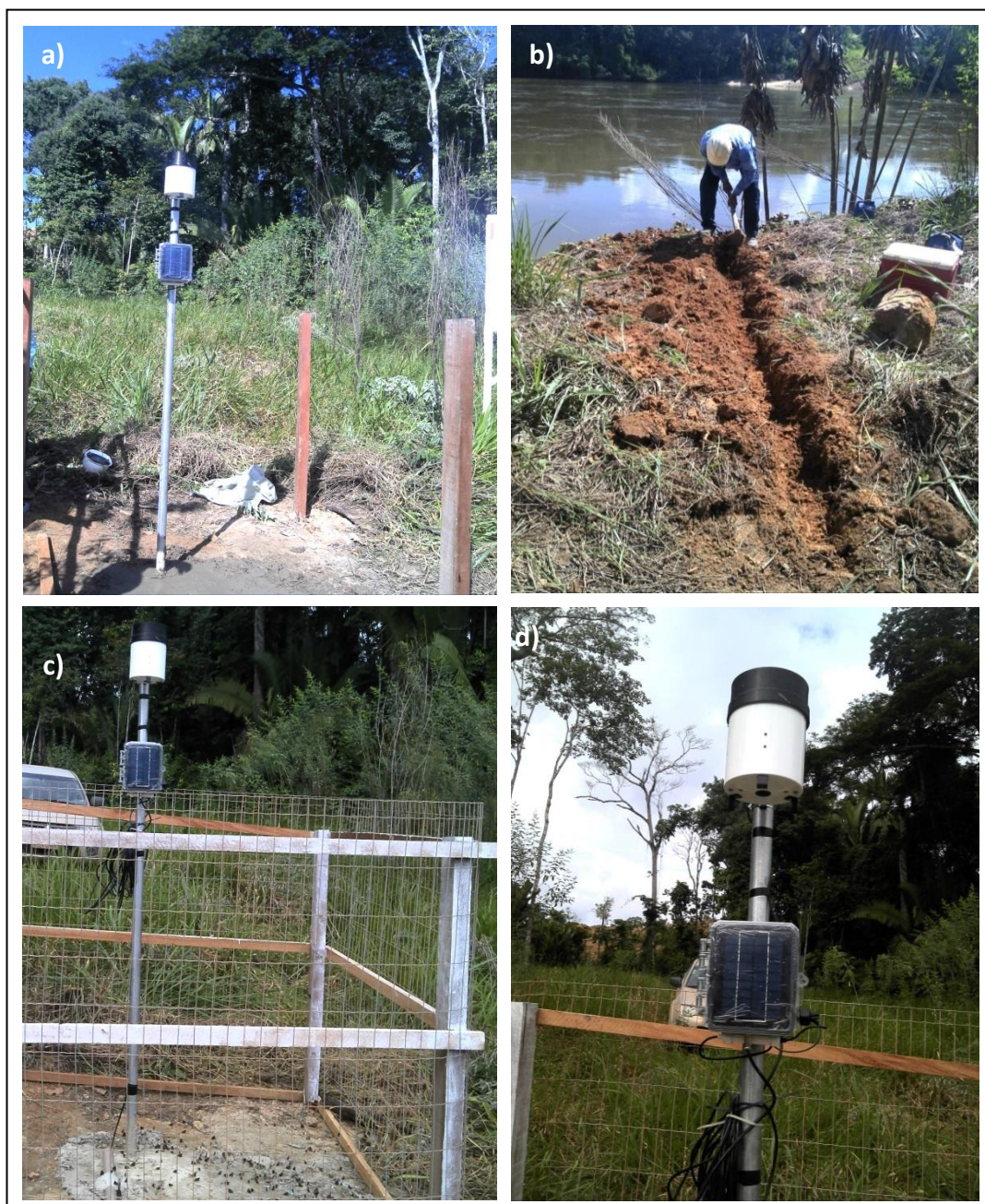
Figura 3. Processo de instalação da nova estação UHE Teles Pires durante a campanha de campo de maio de 2014, incluindo o poste para suporte (a); canaleta para o sensor de nível (b); cercado (c); pluviômetro e datalogger (d).
