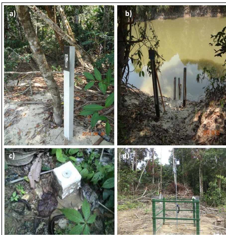
Figura 5. Processo de instalação da estação hidrométrica São Pedro do Paranaíta, incluindo o PI (a); lance de régua (b); RN (c); e vista geral da estação (d).
