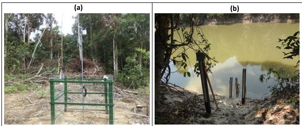
Figura 10. Montagem e instalação da estação hidrométrica Paranaíta. (a) Visão geral da estação sendo montada; (b) Visão geral do local escolhido para a instalação da estação.
