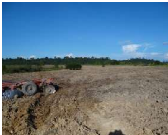
Figura 08. Vista geral da área R01/A2 já preparada para o plantio.
