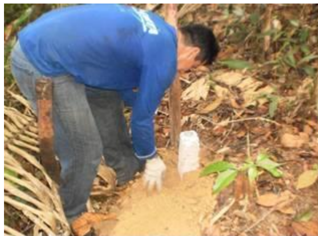
Colocação de Marco Demarcatório
