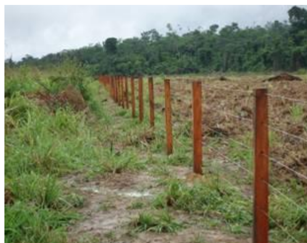
UHETP- 11 –Cerca Finalizada
