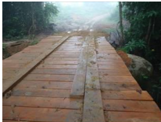
UHETP- 38 – Ponte Finalizada
