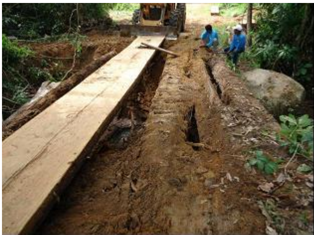
UHETP- 38 – Reconstrução de Ponte
