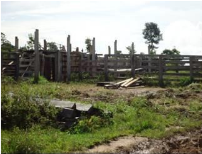
UHETP- 12 – Demolição Curral
