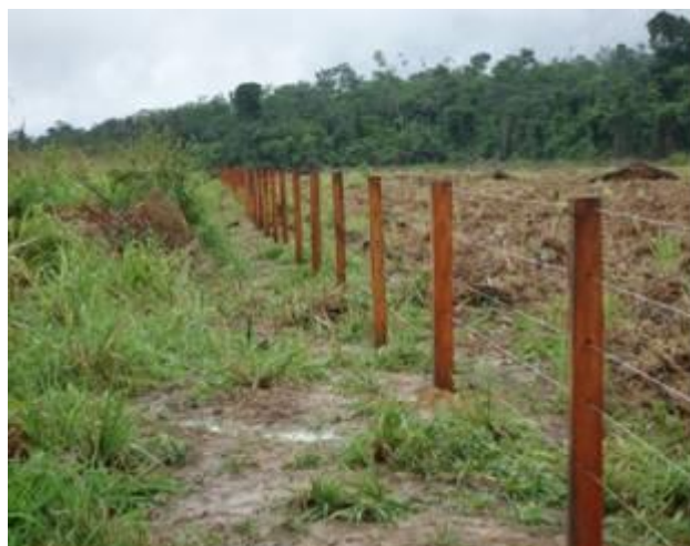
UHETP- 11 –Cerca Finalizada
