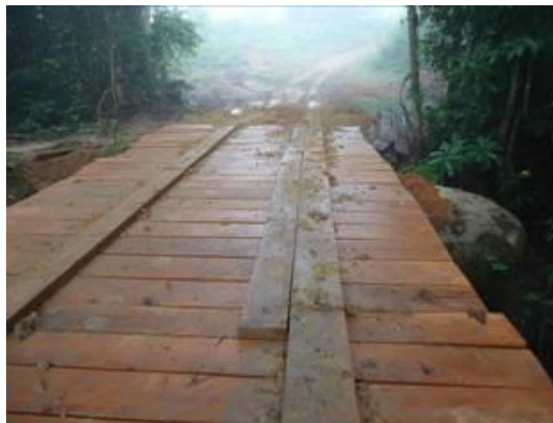
UHETP- 38 – Ponte Finalizada
