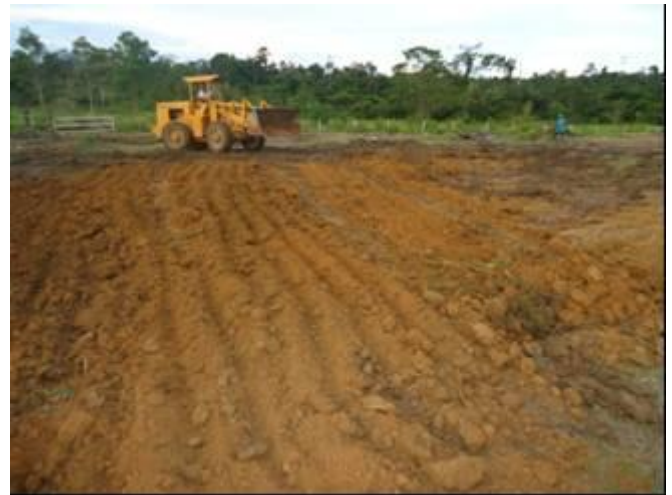
UHETP- 12 – Limpeza Concluída
