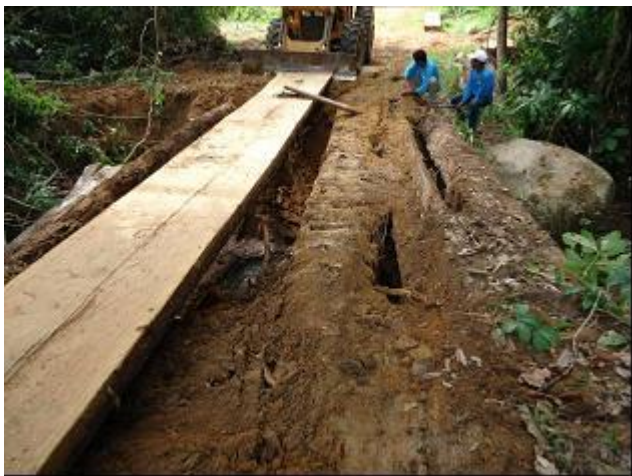
UHETP- 38 – Reconstrução de Ponte
