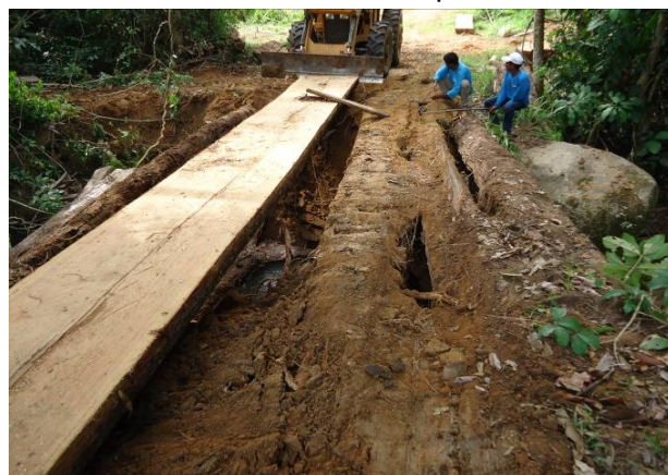
Desdobramento madeira para Ponte
