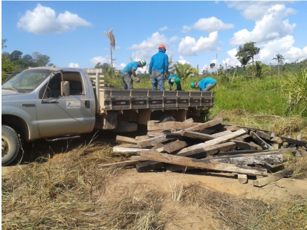
Retirada de cerca Existente
