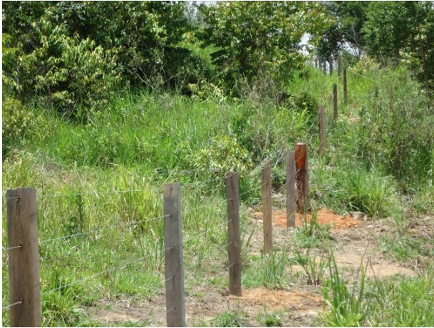
Construção de cerca
