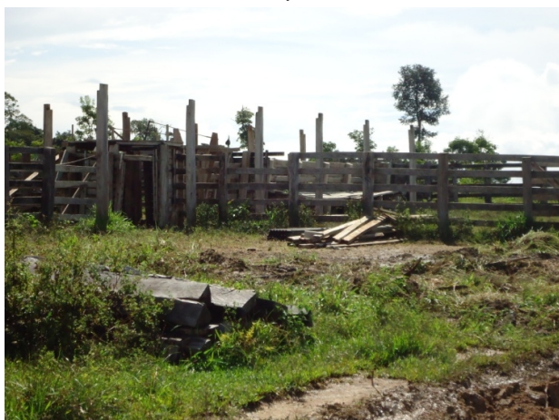
Demolição Curral Propriedade
