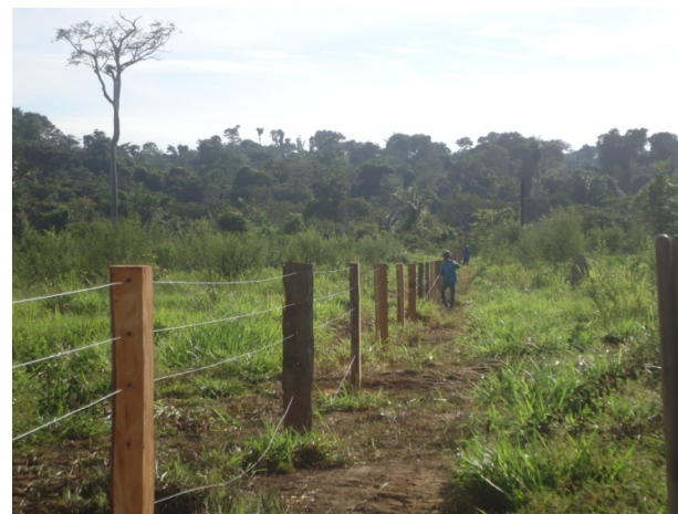
Construção de Cerca
