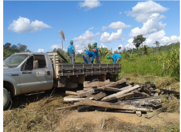
Retirada de cerca existente
