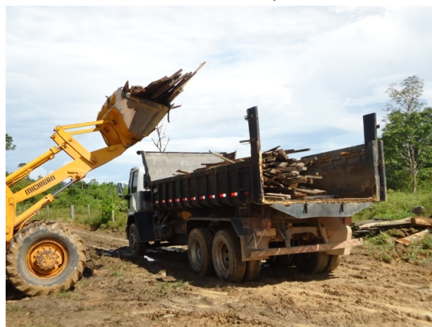
Retirada de entulho
