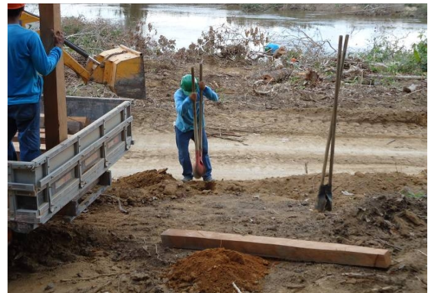
Construção e recuperação de cerca
