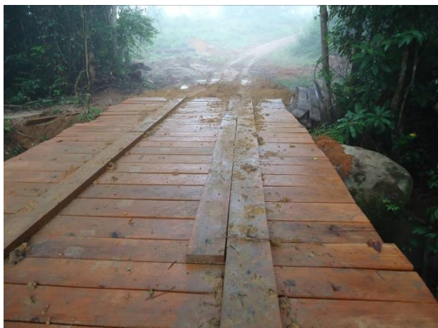
Construção de Ponte Finalizada (01) DEPOIS
