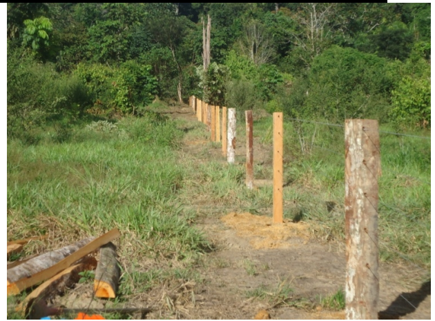
Construção de Cerca
