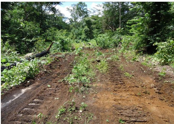
Limpeza de Estrada
