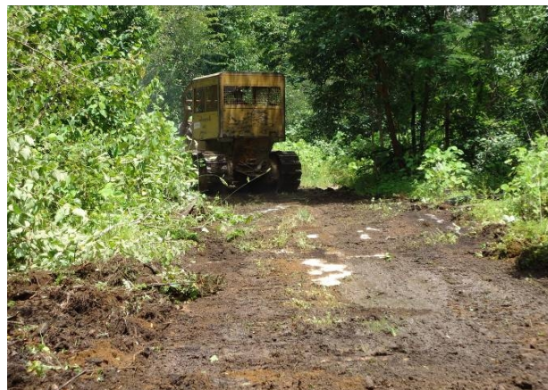
Limpeza de Estrada
