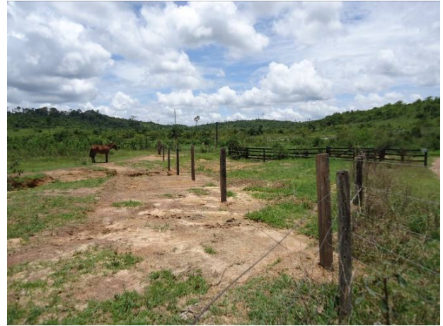
Construção de cerca
