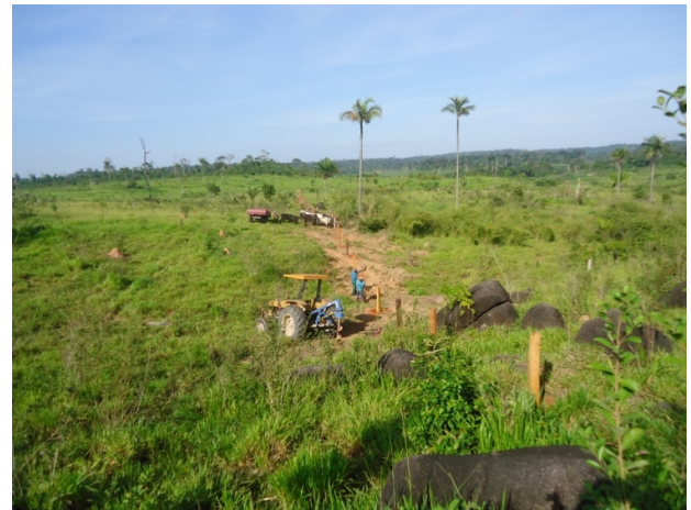
Construção de cerca
