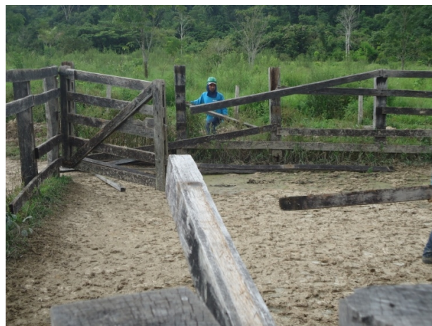
Demolição Curral Propriedade
