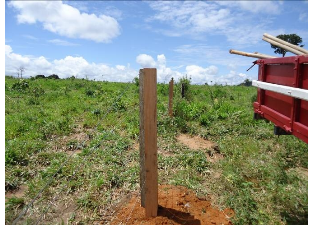
Construção e recuperação de cerca
