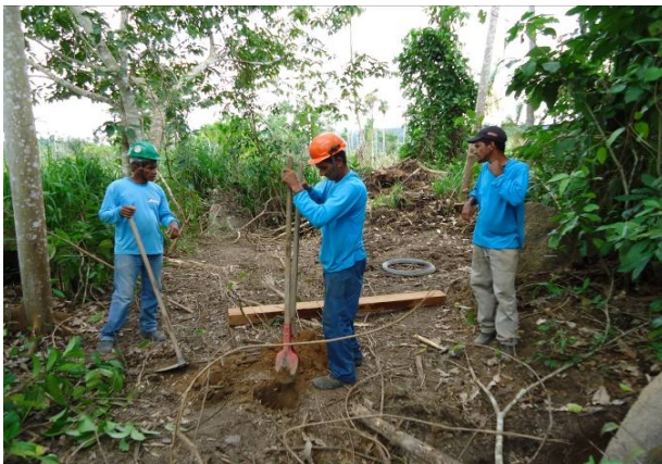
Construção e recuperação de cerca
