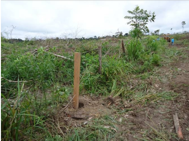
Construção e recuperação de cerca
