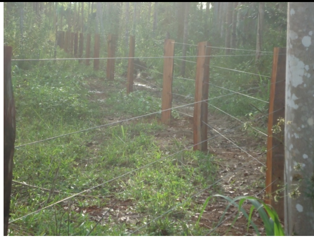
Construção de Cerca
