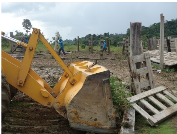
Utilização máquina para demolição da mangueira
