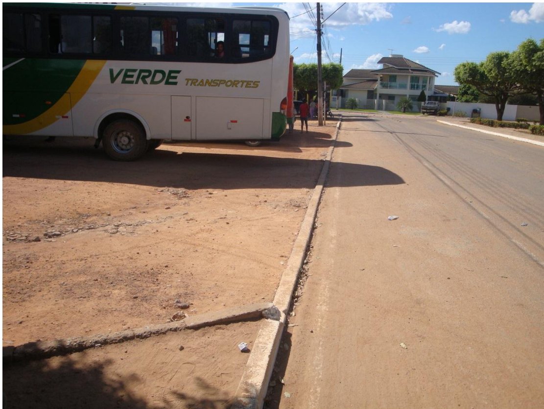
Figura 4: Espaço/pátio inadequado para a manobra dos ônibus colocando em risco a segurança de pessoas que transitam pelo local.
