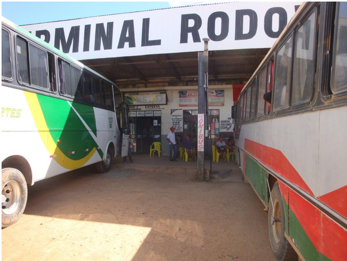
Figura 5: Ausência de divisão entre plataformas dos ônibus, passageiros não possuem local adequado para espera.
