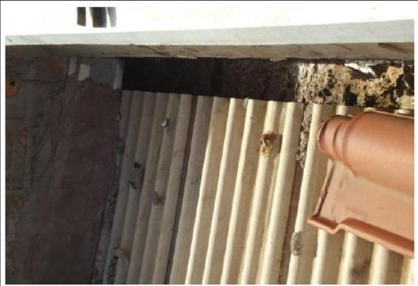
**Figura 08: Vazamento na calha da caixa de água Unidade Previdenciária de Paranaíta.**
