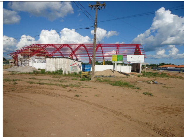
Foto 1. Obras de Construção do Ginásio Poliesportivo de Jacareacanga.
