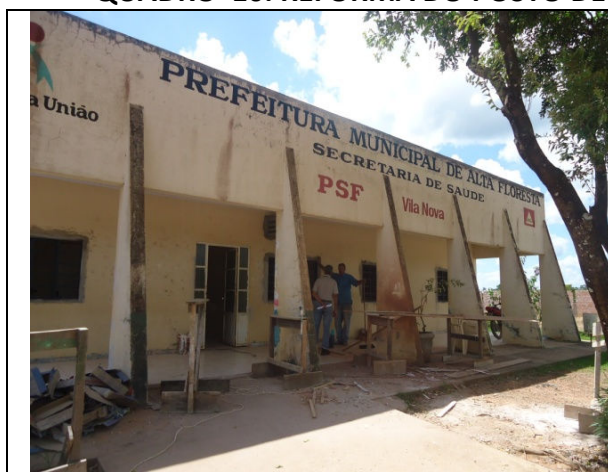
Foto 1. Vista Frontal do Prédio do PSF em reforma.
