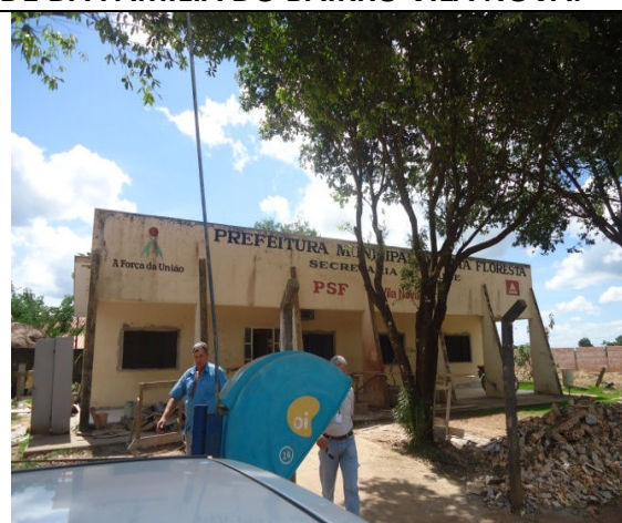
Foto 2. Vista Frontal do Prédio do PSF em reforma.
