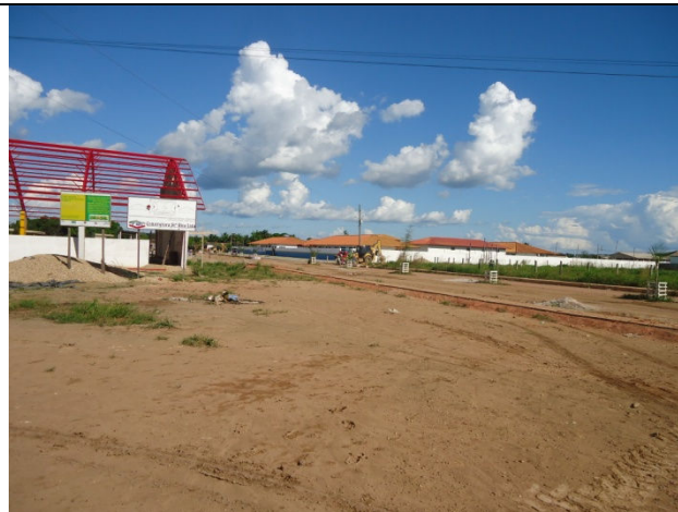
Foto 2. Obras de Construção do Ginásio Poliesportivo de Jacareacanga.
