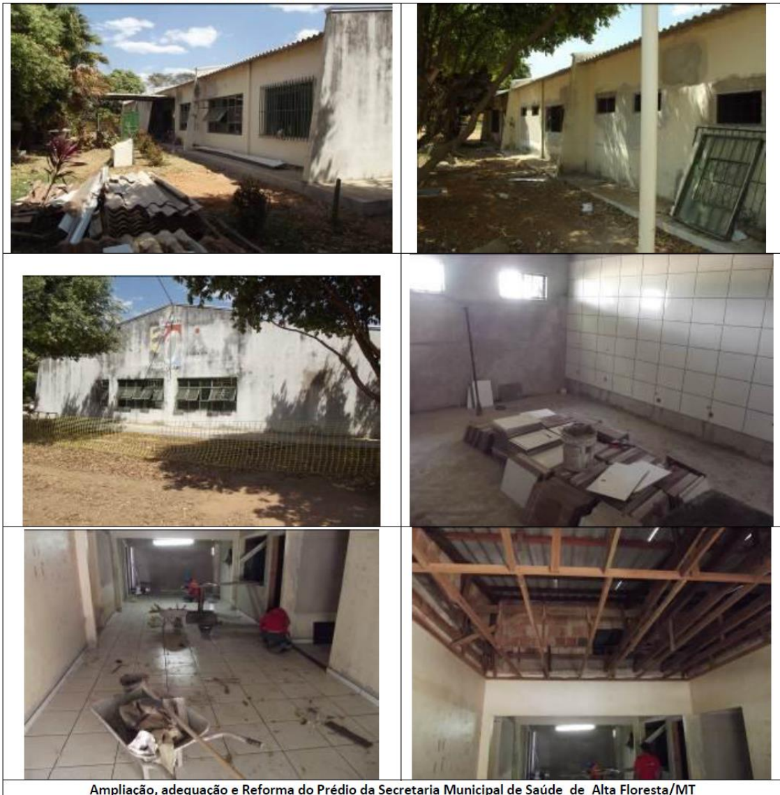
Ampliação, adequação e Reforma do Prédio da Secretaria Municipal de Saúde de Alta Floresta/MT
