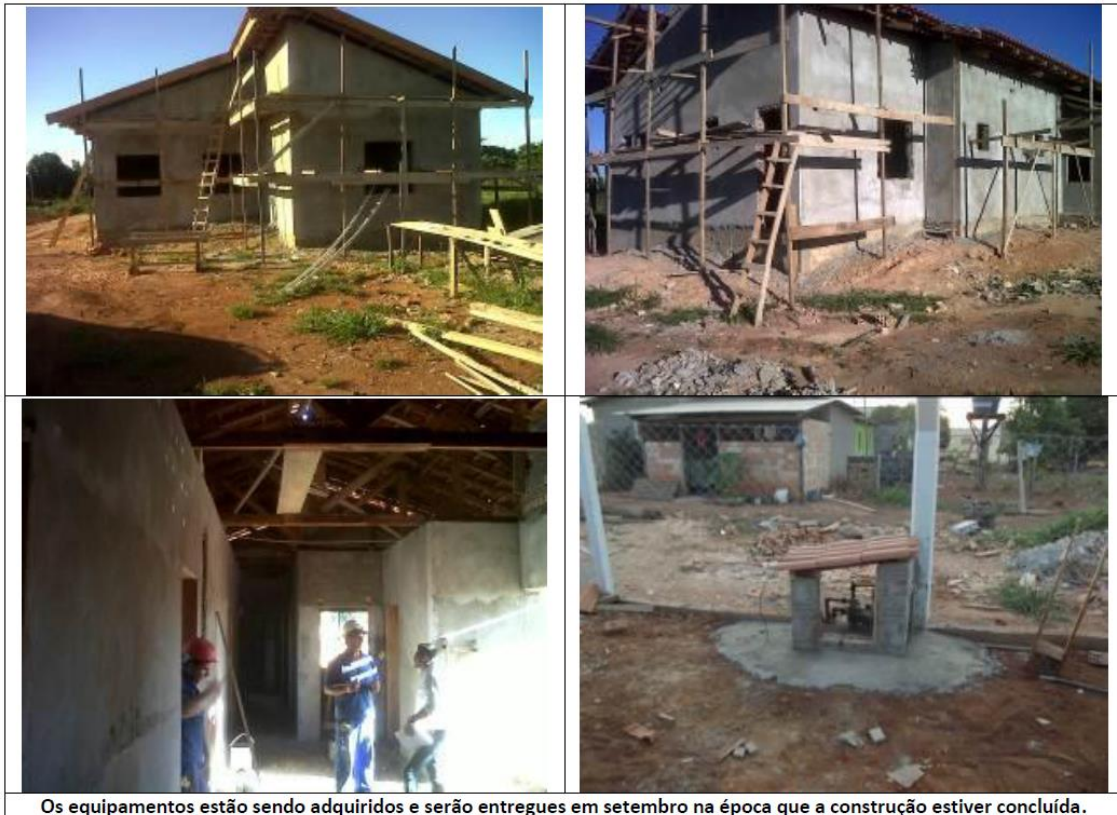
Os equipamentos estão sendo adquiridos e serão entregues em setembro na época que a construção estiver concluída.
