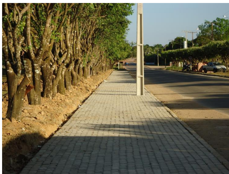
Fotografia 20. Construção de Pista de Caminhada.
