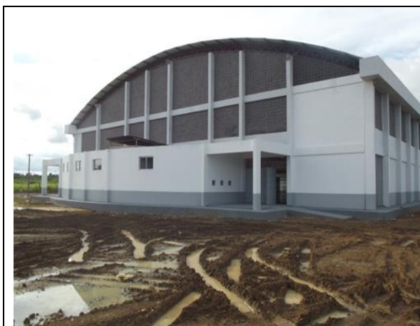
Figura 24: Construção do Ginásio Poliesportivo de Jacareacanga.
