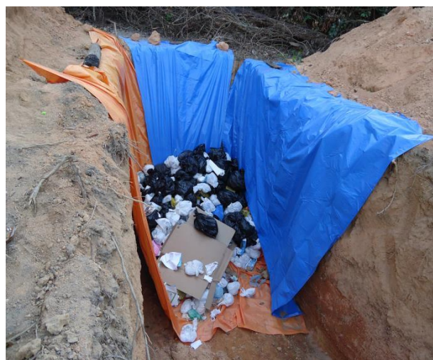
Fotografia 18. Vala para Lixo Hospitalar sendo depositado sem nenhum critério de tratamento.
