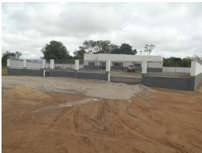
Fotografia 12. Construção da Nova Sede da Delegacia de Polícia Civil de Paranaíta.
