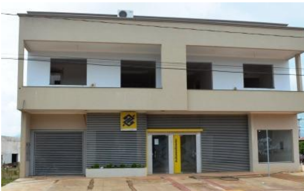
Fotografia 03. Instalações do Banco do Brasil em Paranaíta durante a etapa final de construção.
