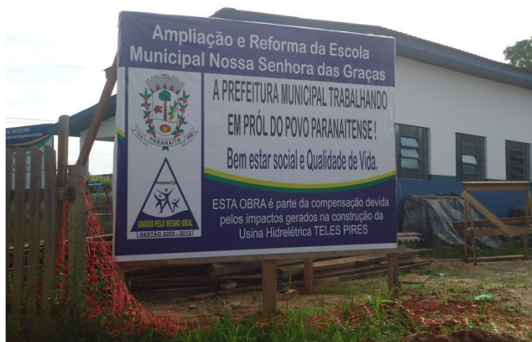
Fotografia 06. Construção pelo Programa P.36/CHTP de 1 (uma) sala de aula na Escola Municipal Nossa Senhora das Graças em Paranaíta.
