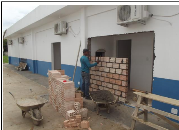
Figura 26. Construção e readequação Centro anexo ao Hospital de Jacareacanga.
