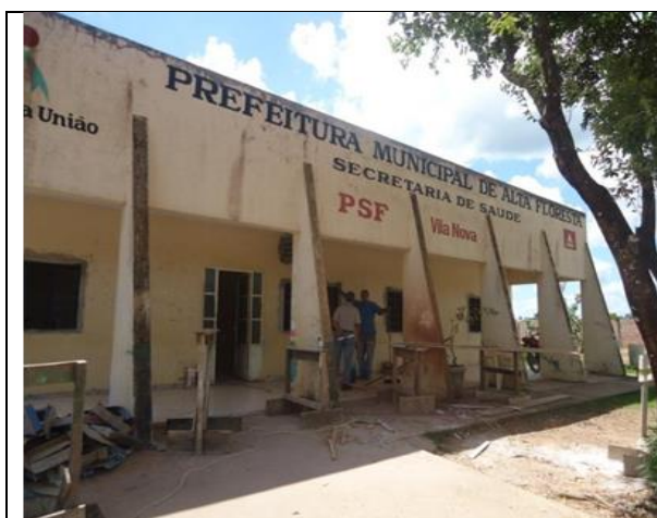
Figura 22: Prédio antes da reforma do PSF Vila Nova para ser utilizado como Posto Policial.
