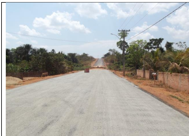
Figura 23: Pavimentação Av. Teles Pires
