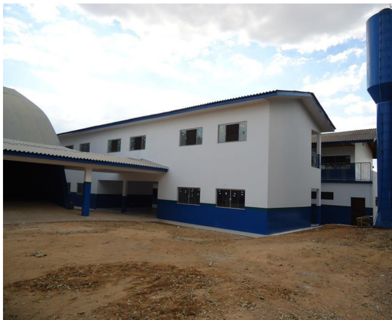
Fotografia 05 – Pavilhão com 7 (sete) salas de aula construídas pela CHTP na Escola Municipal Juscelino Kubitschek em Paranaíta.
