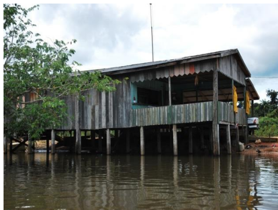
Figura 6. Moradia suspensa a margem do rio.
