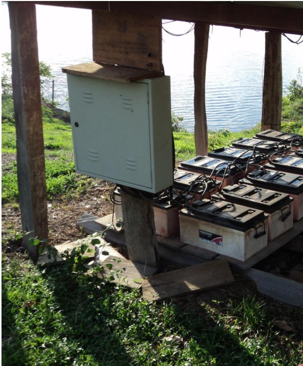
Figura 22: Manutenção no sistema solar da aldeia Teles Pires.
