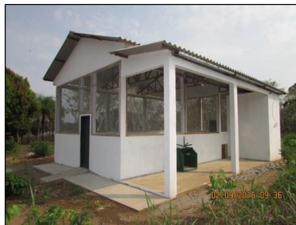
Foto 08 - Set/16: Vista lateral da edificação, com execução de calçada da fachada.
