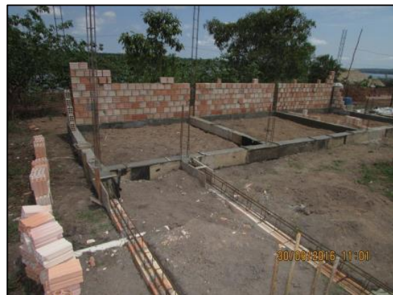
Foto 90 - Set/16: Início de execução da alvenaria.
