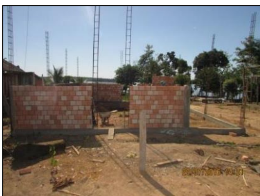
Foto 39 - Jul/16: Alvenaria lado externo.
