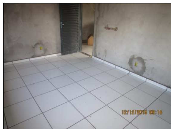
Foto 118 - Dez/16: Execução de reboco e instalação de revestimento cerâmico na Sala de Reuniões.
