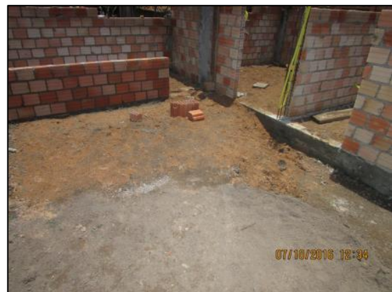
Foto 92 - Out/16: Aterro para compactação do solo.
