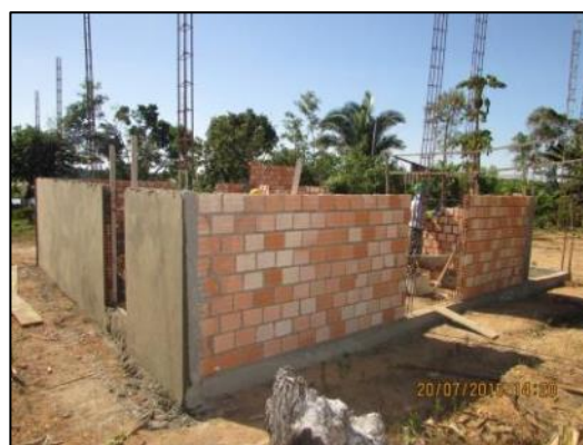
Foto 40 - Jul/16: Execução de reboco da alvenaria.
