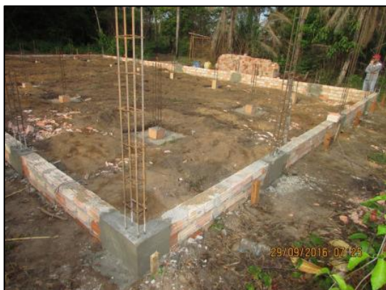
Foto 73 - Set/16: Concretagem das vigas baldrame para fundação da estrutura.
