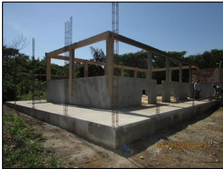
Foto 81 - Nov/16: Vista lateral externa da edificação.
