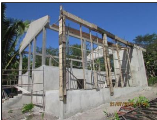
Foto 13 - Jul/16: Concretagem dos pilares da estrutura.
