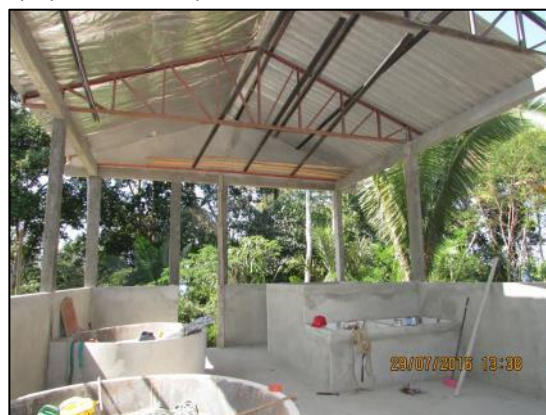
Foto 18 - Jul/16: Vista interna da edificação coberta com fornos e tanques.
