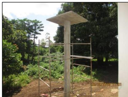
Foto 60 - Dez/16: Execução de suporte em alvenaria para instalação de caixa d'água.
