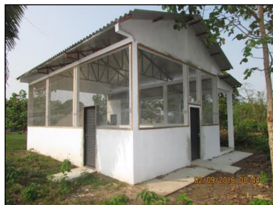
Foto 10 - Set/16: Vista lateral da edificação, com execução de calçada da fachada.
