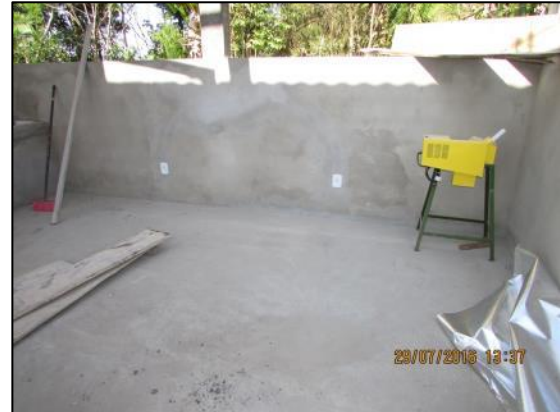
Foto 20 - Jul/16: Execução de reboco da alvenaria interna e contrapiso.
