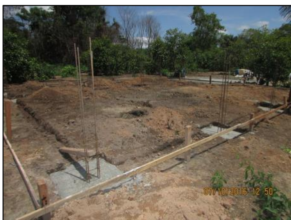
Foto 69 - Out/16: Concretagem de sapatas da fundação.
