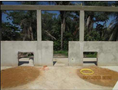
Foto 79 - Nov/16: Aberturas para instalação de esquadrias e fornos.
