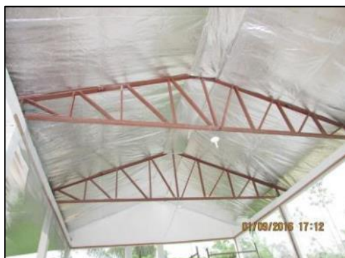
Foto 29 - Set/16: Instalação de manta térmica da cobertura.
