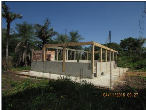
Foto 80 - Nov/16: Vista externa da edificação.
