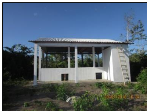
Foto 26 - Jul/16: Vista lateral da edificação com abertura dos fornos.
