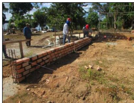
Foto 38 - Jul/16: Início de execução de alvenaria.
