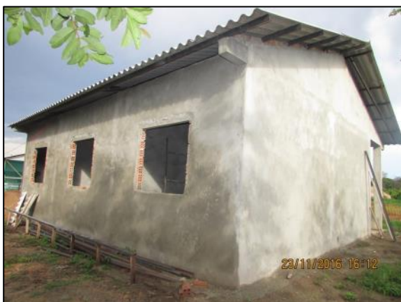
Foto 101 - Nov/16: Vista externa dos fundos da construção.
