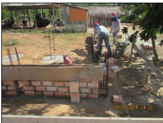
Foto 37 - Jul/16: Início de execução de alvenaria.
