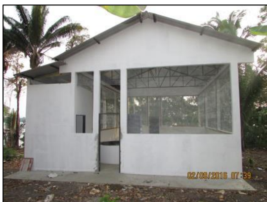
Foto 23 - Set/16: Vista frontal de fachada em instalação de tela.
