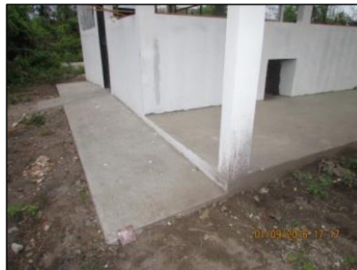
Foto 32 - Set/16: Execução de calçada na fachada.
