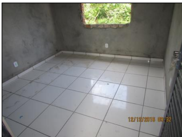
Foto 105 - Dez/16: Instalação de revestimento cerâmico no quarto da Casa de Apoio.
