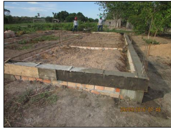
Foto 88 - Set/16: Concretagem de vigas baldrame da fundação.
