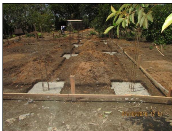
Foto 70 - Out/16: Concretagem de sapatas da fundação.
