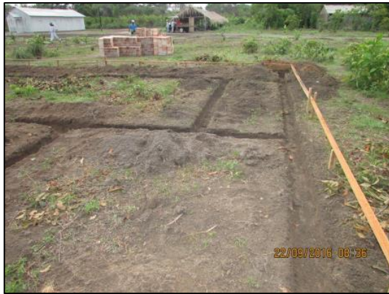
Foto 87 - Set/16: Marcação de gabarito da obra.
