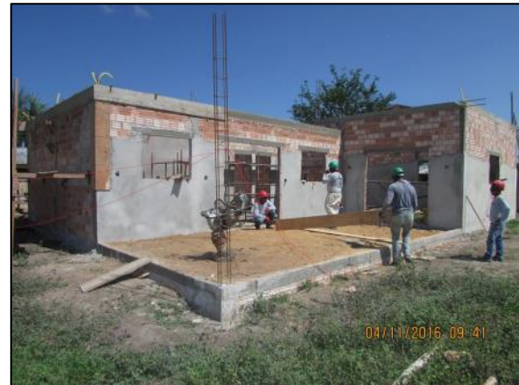
Foto 112 - Nov/16: Execução de reboco da alvenaria externa e aterro para compactação de solo da varanda.
