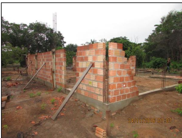
Foto 71 - Nov/16: Execução da alvenaria da obra.
