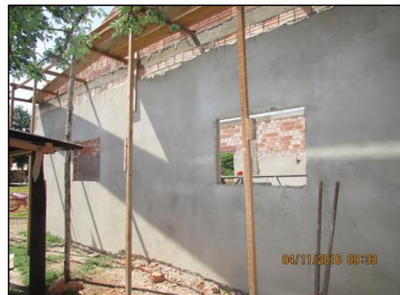
Foto 114 - Nov/16: Execução de reboco da alvenaria externa.
