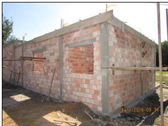
Foto 113 - Nov/16: Alvenaria externa e concretagem de vigas aéreas da estrutura.
