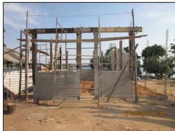
Foto 44 - Ago/16: Concretagem de pilares e vigas aéreas da estrutura.
