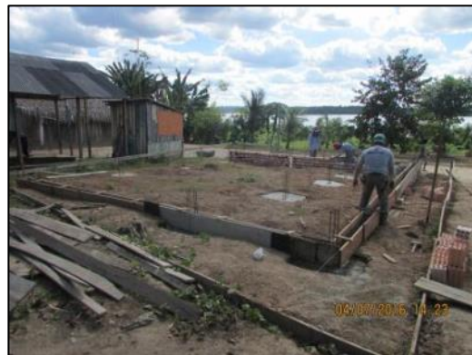
Foto 36 - Jul/16: Concretagem das vigas baldrame da fundação.
