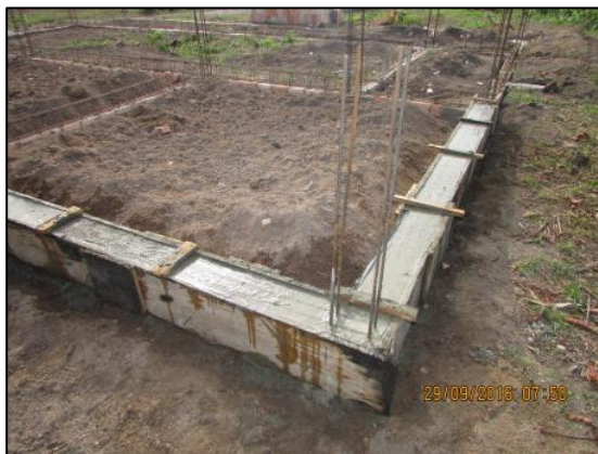
Foto 89 - Set/16: Armação e concretagem de vigas baldrame da fundação.
