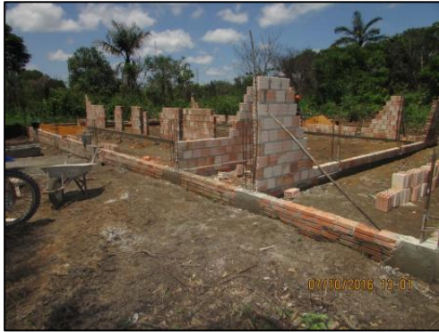
Foto 75 - Out/16: Início de execução da alvenaria.
