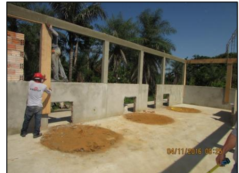
Foto 78 - Nov/16: Execução de reboco e contrapiso interno.
