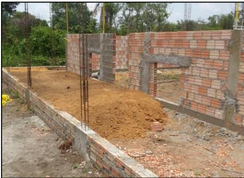
Foto 77 - Out/16: Aterro para compactação de solo da área de varanda.
