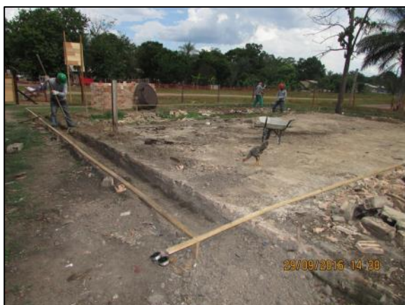
Foto 107 - Set/16: Marcação de gabarito da obra.
