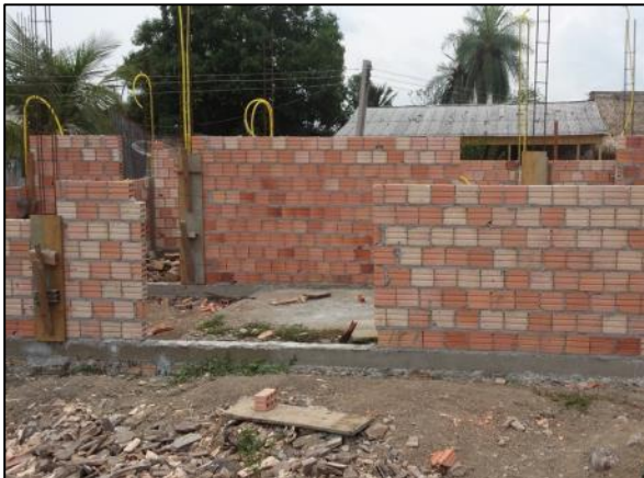
Foto 111 - Out/16: Execução de alvenaria.
