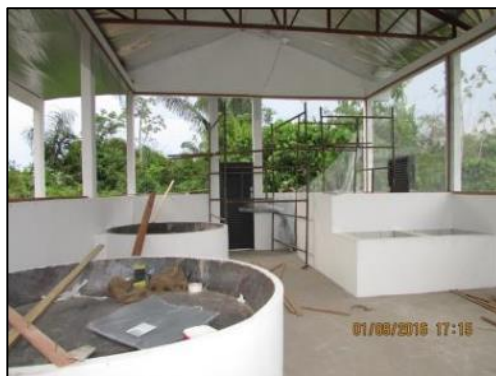
Foto 28 - Set/16: Vista interna da Farinheira, execução de revestimento cerâmico dos tanques, contrapiso e pintura.
