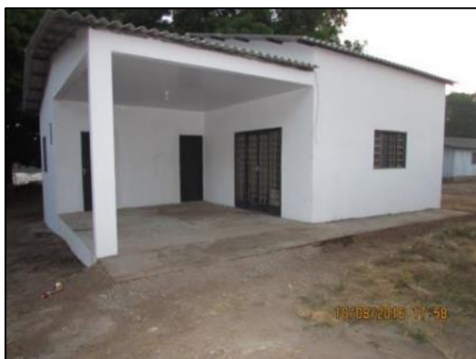
Foto 59 - Ago/16: Vista externa da Casa de Artesanato, com execução de calçada na lateral, instalação de forro de PVC e pintura.
