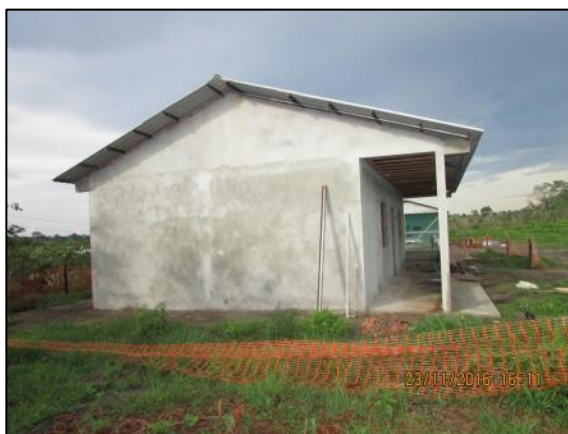
Foto 102 - Nov/16: Vista lateral externa da edificação.
