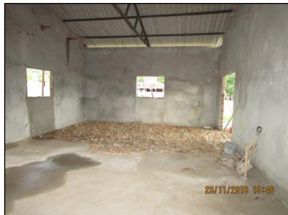
Foto 116 - Nov/16: Vista interna da área de galpão com cobertura, aterro de solo e contrapiso.
