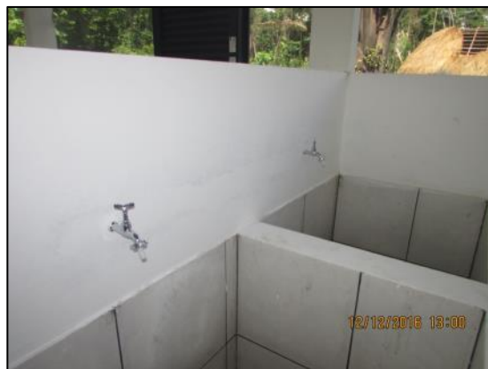
Foto 12 - Dez/16: Instalação de torneiras dos tanques.
