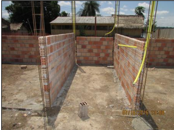
Foto 109 - Out/16: Execução de alvenaria e passagem de fiação embutida nos conduites para ligação elétrica.
