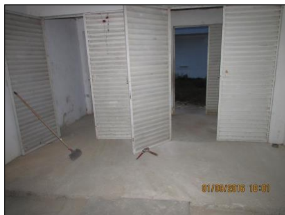
Foto 62 - Set/16: Melhorias no Abrigo de Resíduos sólidos hospitalares, como recuperação de portas danificadas, revestimento cerâmico e pintura.
