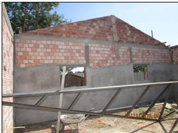
Foto 115 - Nov/16: Execução de reboco da alvenaria interna.
