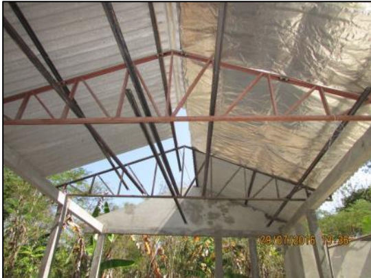
Foto 19 - Jul/16: Instalação de cobertura e manta térmica.
