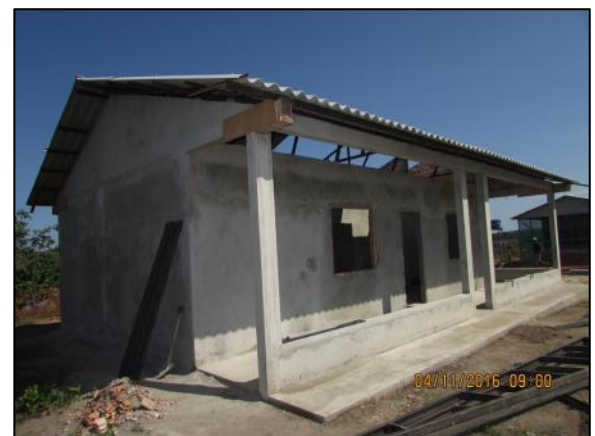
Foto 98 - Nov/16: Vista lateral externa da edificação com execução de calçada na fachada.
