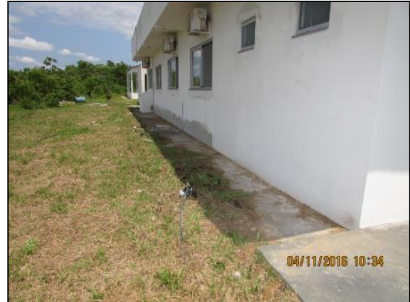
Foto 64 - Nov/16: Vista lateral externa da edificação durante atividades de reforma.
