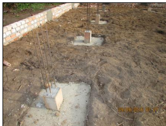
Foto 74 - Set/16: Concretagem de sapatas da fundação.
