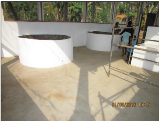
Foto 49 - Set/16: Confeção dos fornos e execução de contrapiso.
