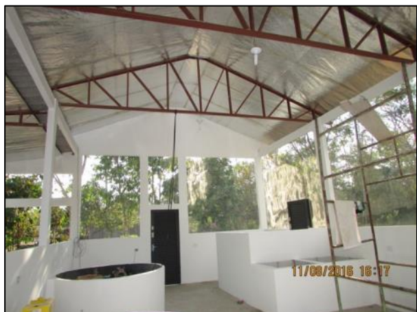
Foto 03 - Ago/16: Vista interna da Farinheira, com instalação de manta e pintura concluídas.
