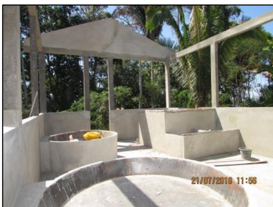
Foto 17 - Jul/16: Execução de fornos e revestimento cerâmico dos tanques de pubagem.
