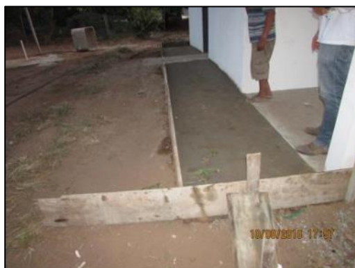
Foto 53 - Ago/16: Execução de calçada na fachada.
