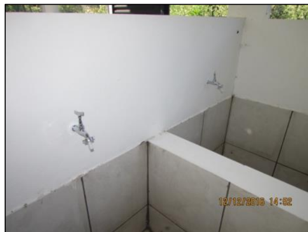
Foto 04 - Dez/16: Instalação de torneiras dos tanques.
