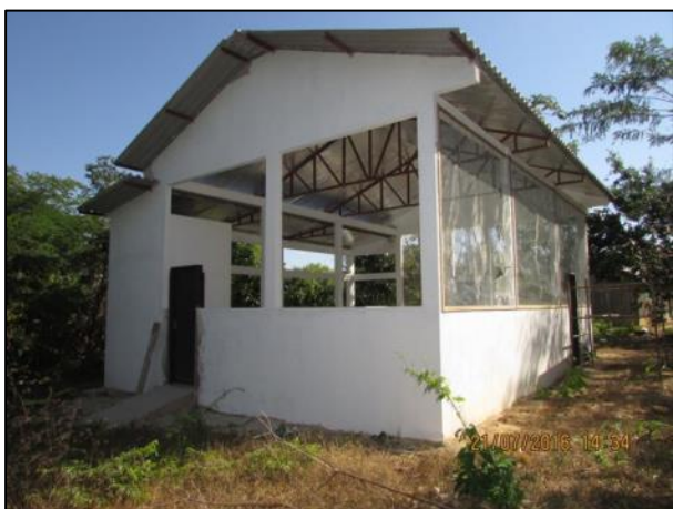
Foto 01 - Jul/16: Vista externa da edificação, em acabamento de tela.
