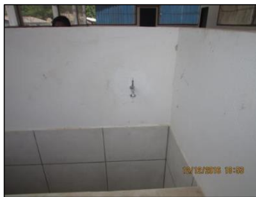
Foto 56 - Dez/16: Instalação de torneiras dos tanques.
