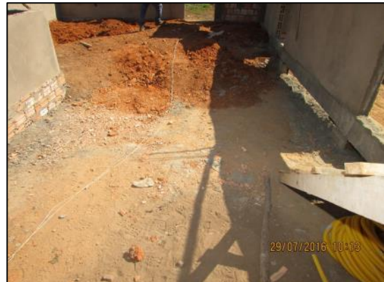
Foto 42 - Jul/16: Execução de aterro para compactação do solo.
