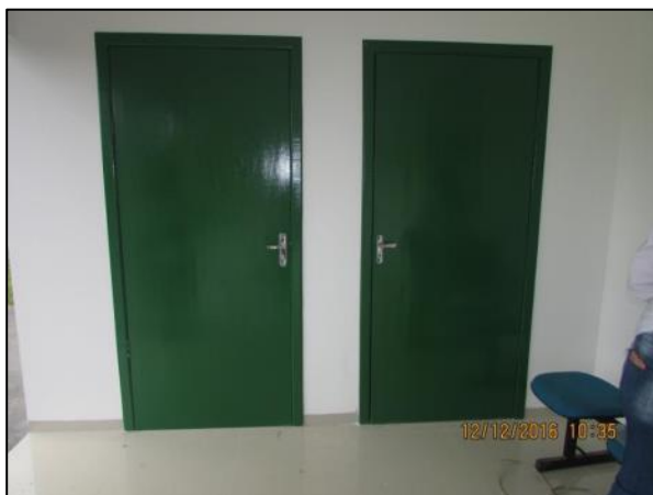
Foto 67 - Dez/16: Regularização e recuperação das portas com pintura lavável.
