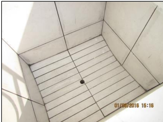
Foto 47 – Set/16: Instalação de revestimento cerâmico dos tanques.
