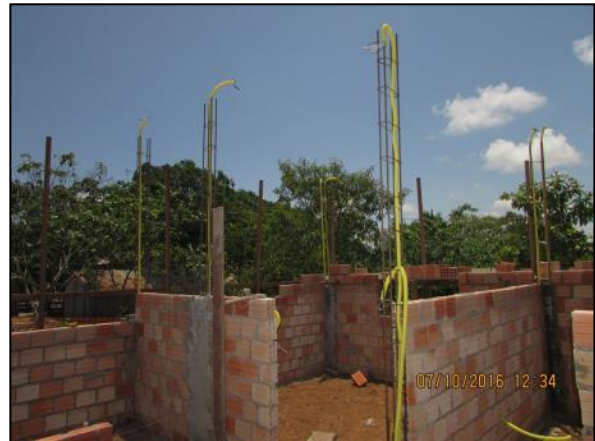
Foto 94 - Out/16: Passagem de fiação embutida nos conduites para ligação elétrica.
