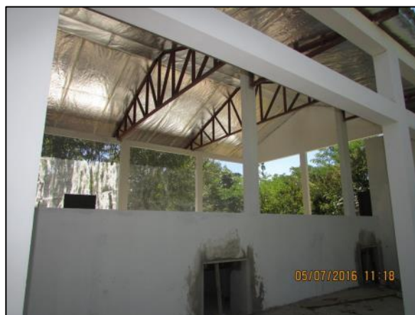
Foto 06 - Jul/16: Instalação de manta térmica e abertura do vão do forno.
