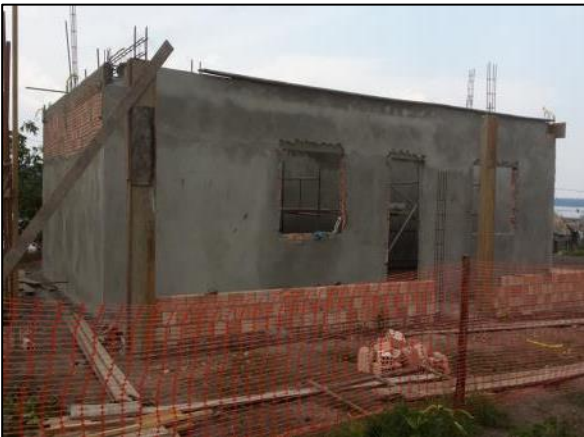
Foto 95 - Out/16: Execução de reboco da alvenaria externa.
