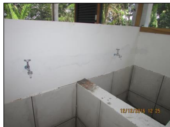
Foto 24 - Dez/16: Instalação de torneiras dos tanques.
