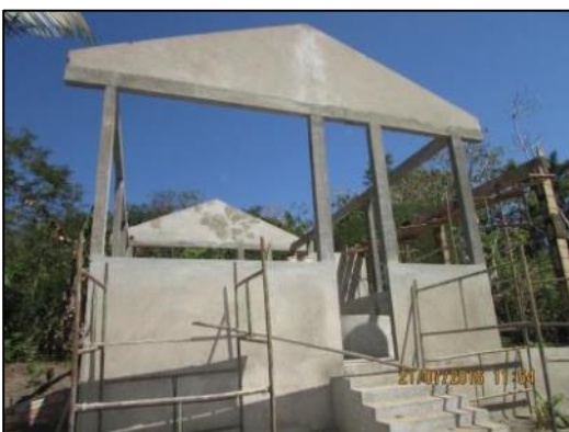
Foto 15 - Jul/16: Execução de reboco da alvenaria externa.
