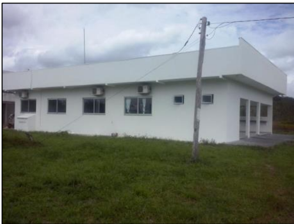
Foto 65 - Nov/16: Vista externa da edificação pós execução de pintura.
