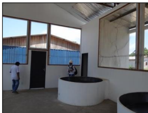
Foto 54 - Dez/16: Vista interna da Farinheira com fornos, manta térmica e pintura.
