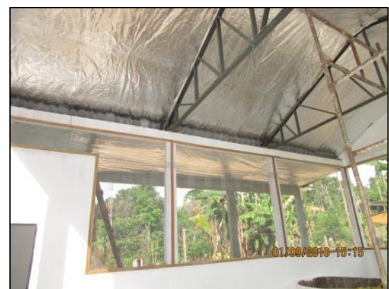
Foto 46 - Set/16: Instalação de tela e manta térmica.
