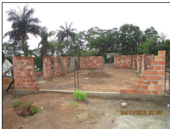
Foto 72 - Nov/16: Execução da alvenaria da obra.
