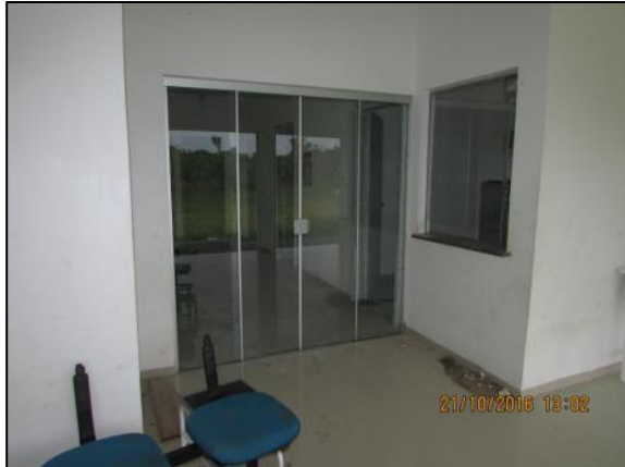
Foto 63 - Out/16: Substituição da porta principal de entrada do PSI, com instalação de porta corrediça duas folhas de blindex.
