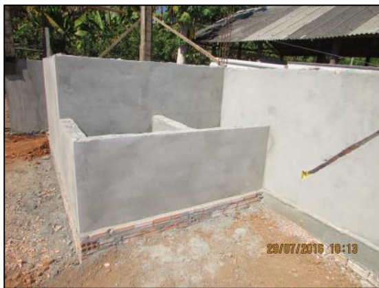
Foto 43 - Jul/16: Confeção e reboco dos tanques de pubagem.
