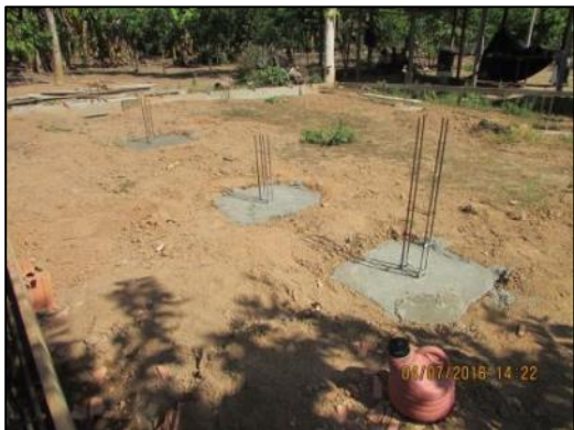
Foto 35 - Jul/16: Concretagem das sapatas da fundação.
