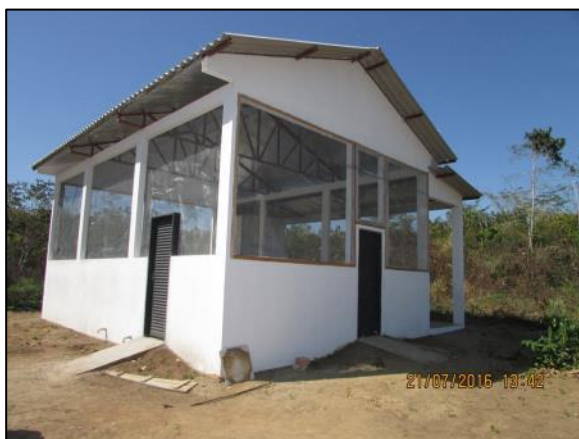
Foto 05 - Jul/16: Vista externa da edificação, em acabamento de tela e execução de rampas de acesso nas portas.
