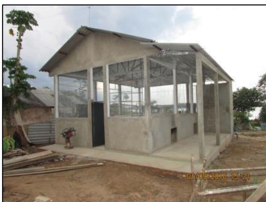
Foto 51 - Set/16: Vista externa da fachada da edificação com execução de calçada.
