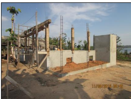
Foto 45 - Ago/16: Vista lateral externa da Farinheira.
