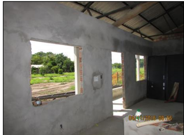
Foto 96 - Nov/16: Execução de reboco da alvenaria interna.
