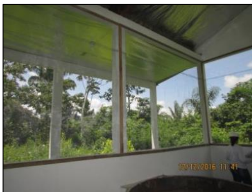
Foto 33 - Dez/16: Instalação de tela.
