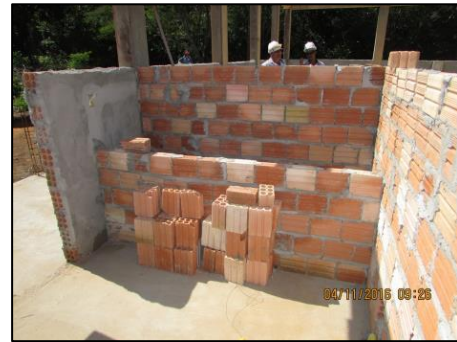
Foto 82 - Nov/16: Execução do tanque de lavagem em alvenaria.
