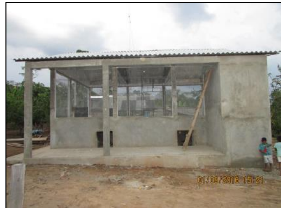
Foto 48 - Set/16: Vista lateral da varanda.
