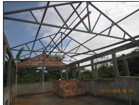
Foto 86 - Dez/16: Vista interna da Farinheira com instalação de estrutura metálica para cobertura da construção.
