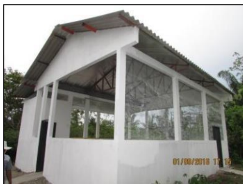
Foto 30 - Set/16: Vista lateral externa da edificação.
