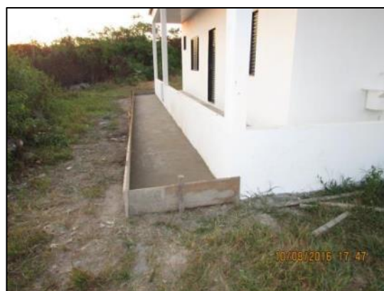
Foto 58 - Ago/16: Execução de calçada na fachada.
