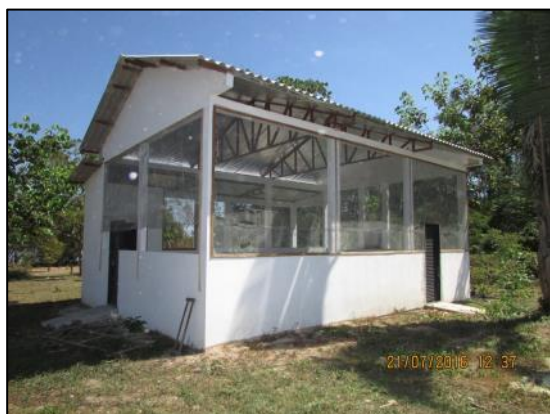
Foto 09 - Jul/16: Vista externa da edificação, em acabamento de tela.
