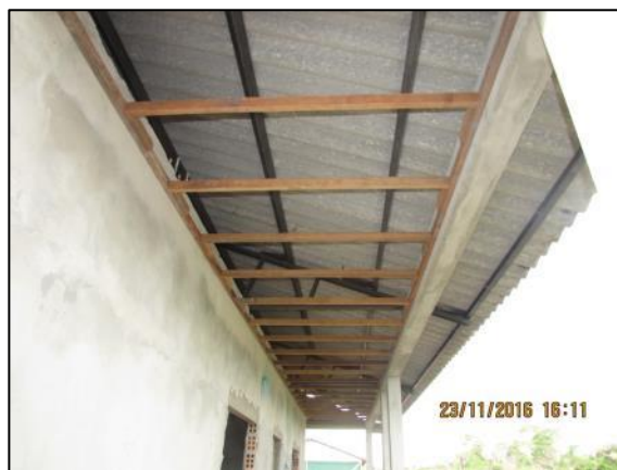
Foto 100 - Nov/16: Madeiramento para instalação de forro de PVC na varanda.
