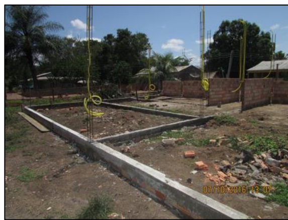
Foto 108 - Out/16: Concretagem de vigas baldrame da fundação.
