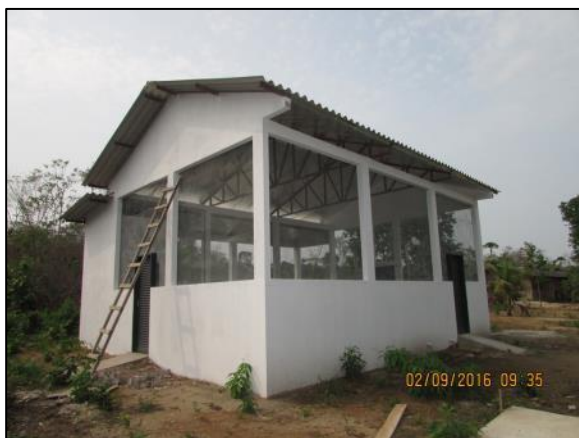
Foto 07 - Set/16: Vista externa da edificação, em demão e retoques finais.
