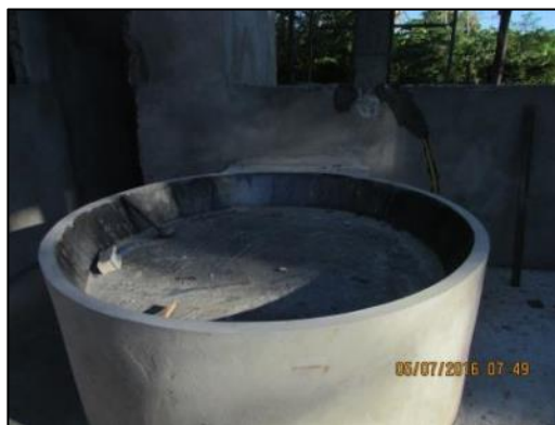
Foto 14 - Jul/16: Confecção dos fornos com tijolo do tipo refratário.
