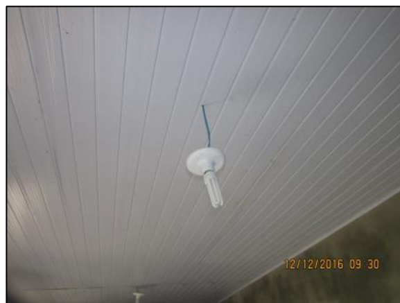
Foto 106 - Dez/16: Instalações elétricas e forro de PVC.
