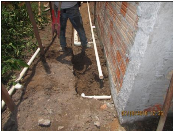
Foto 93 - Out/16: Instalação de tubulação da rede hidráulica.
