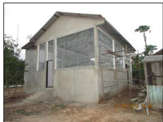
Foto 52 - Set/16: Vista externa dos fundos da construção com execução de escada.
