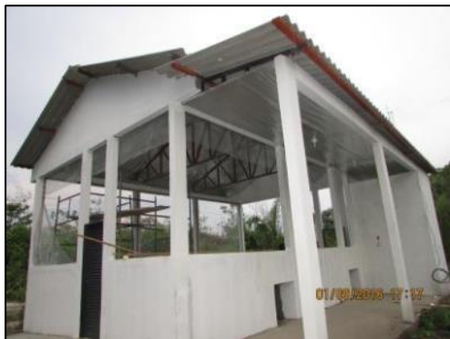
Foto 31 - Set/16: Vista externa de fachada da edificação.
