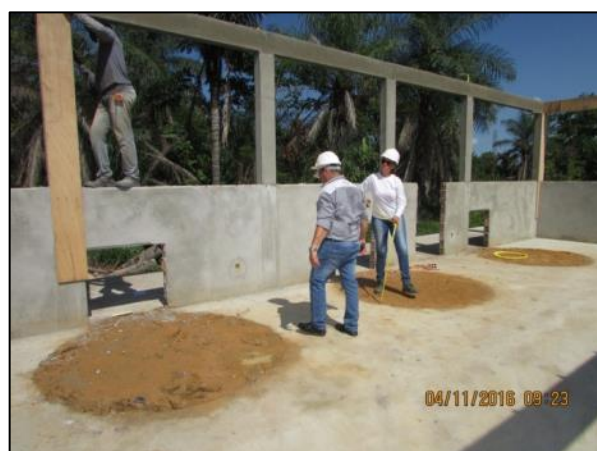
Foto 132 - Nov/16: Vistoria técnica da Casa de Farinha da aldeia Teles Pires (Munduruku).
