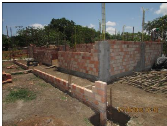
Foto 91 - Out/16: Execução de alvenaria da estrutura.
