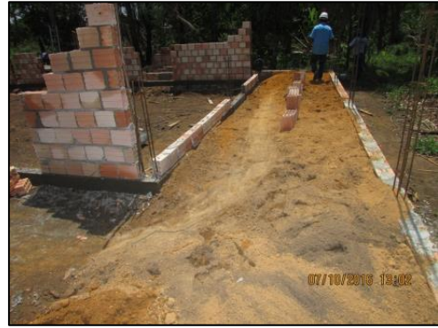
Foto 76 - Out/16: Aterro para compactação de solo.
