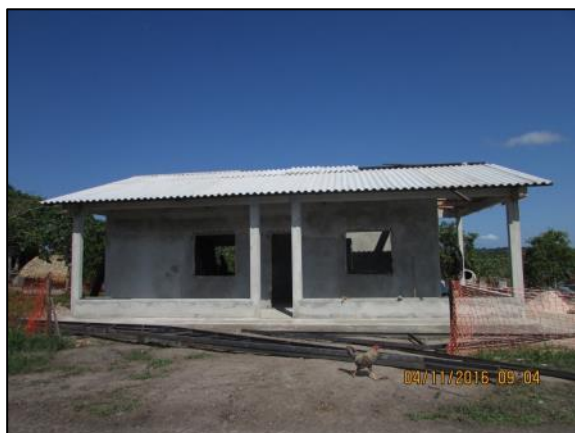
Foto 99 - Nov/16: Vista externa frontal da edificação.
