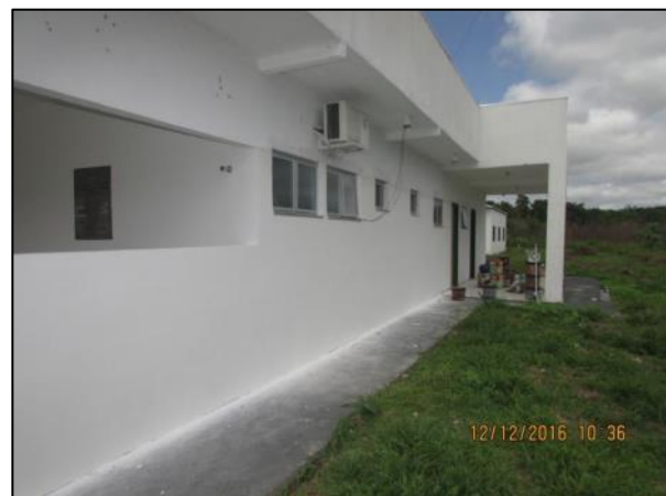
Foto 68 - Dez/16: Emassamento de paredes laterais externas da edificação.
