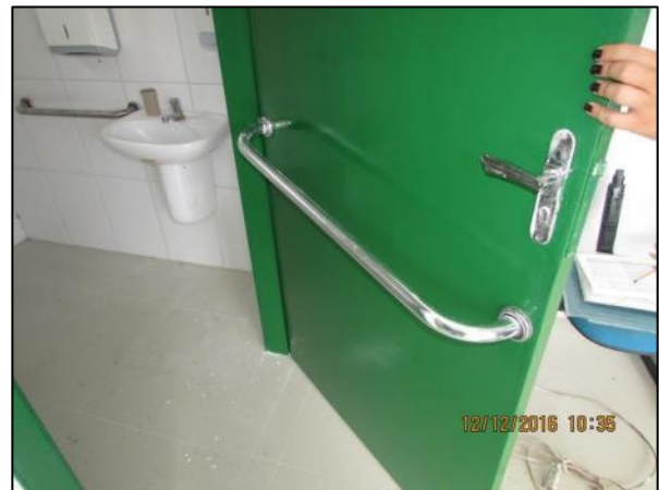
Foto 66 - Dez/16: Instalação de barras de apoio em banheiros para PNE's (Portadores de Necessidades Especiais).
