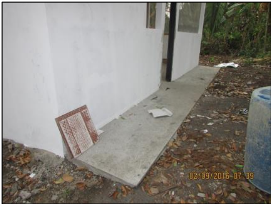
Foto 21 - Set/16: Execução de calçada na fachada.
