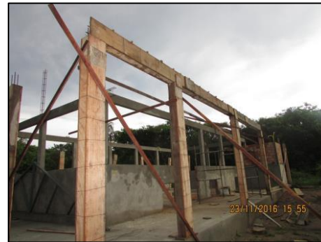
Foto 84 - Nov/16: Concretagem de pilares e vigas aéreas da área externa.
