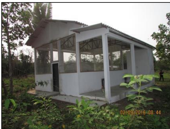
Foto 11 - Set/16: Vista externa da edificação, em demão e retoques finais.
