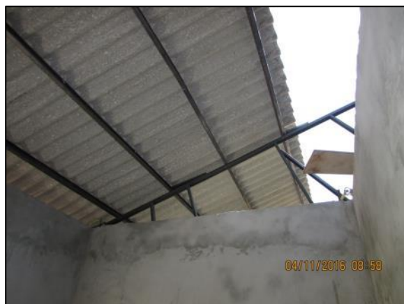
Foto 97 - Nov/16: Instalação de estrutura metálica e telha de fibrocimento da cobertura.
