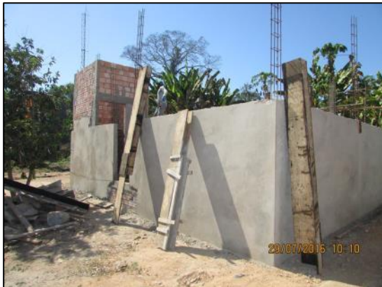
Foto 41 - Jul/16: Execução de reboco da alvenaria.
