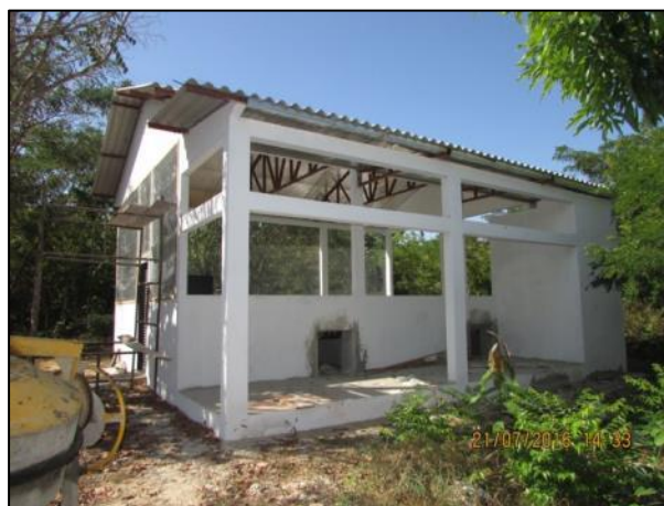
Foto 02 - Jul/16: Vista externa da edificação, em demão e retoques finais.
