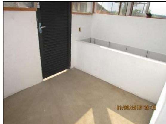
Foto 50 - Set/16: Execução de tanques, instalação de esquadrias e primeira demão de pintura.
