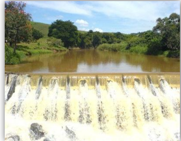
CGH – Ponte Queimada I MG – até 1MW
