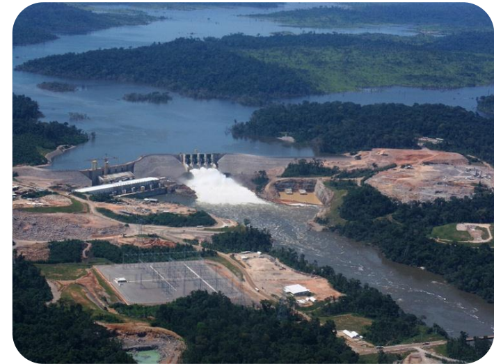
Usina Hidrelétrica Teles Pires
