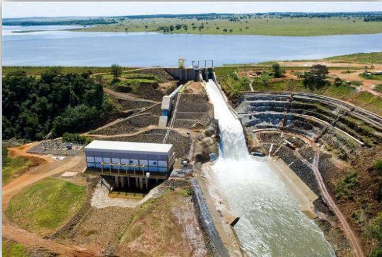
PCH - Retiro Velho em Aporé – GO. Capacidade instalada de 18Mw
