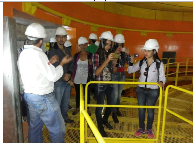
Foto 07 – Visita ao poço da turbina da UHE Teles realizada pelo Grupo de Estudo da EE João Paulo e EE São Pedro - Paranaíta – 15/08/15
