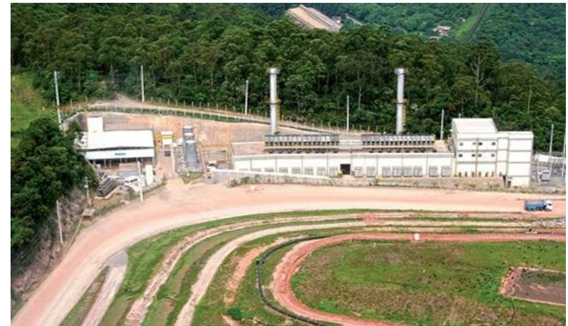
Usina Termoelétrica Biogás, SP
