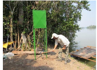
Foto 3 – Instalação das bases fixas.
