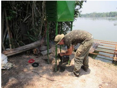
Foto 4 – Instalação das bases fixas.
