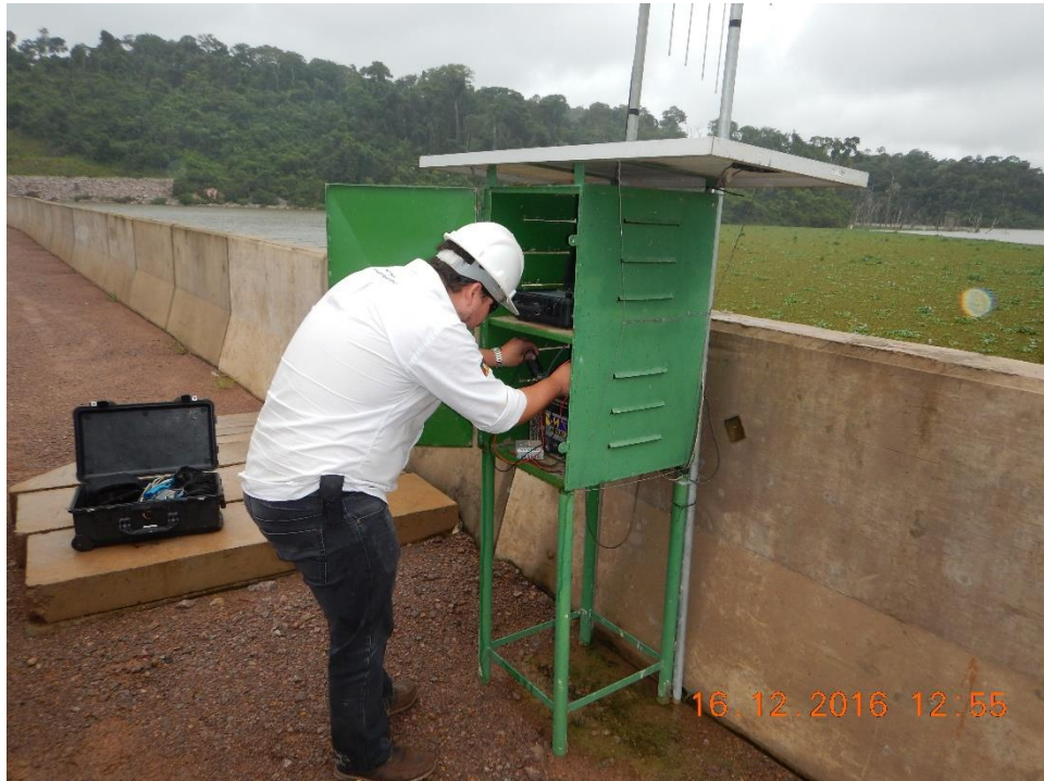
Figura 8: Manutenção de base fixa de radiotelemetria a montante do vertedouro da UHE Teles Pires.
