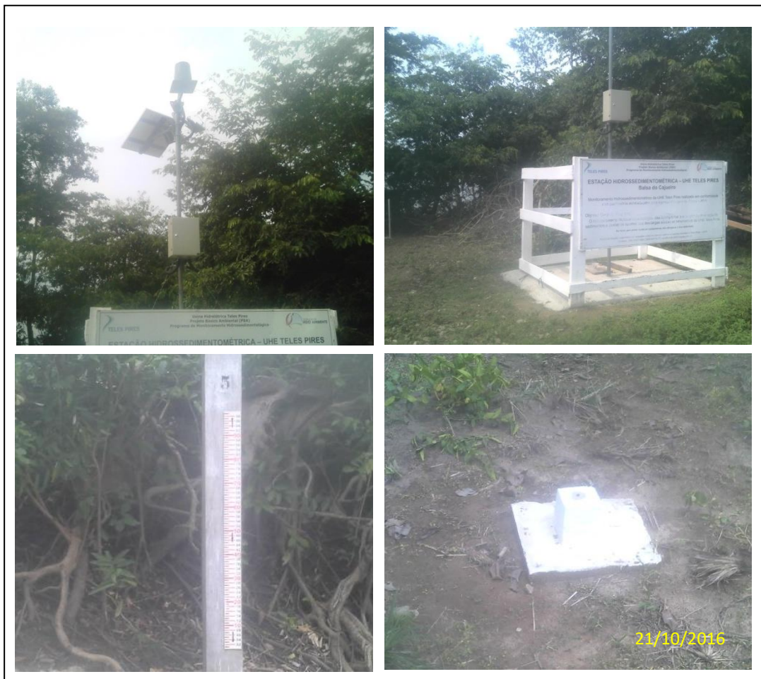
Figura 32. Estação hidrométrica UHE Teles Pires Montante 2 durante vistoria realizada no dia 21 de outubro de 2016.
