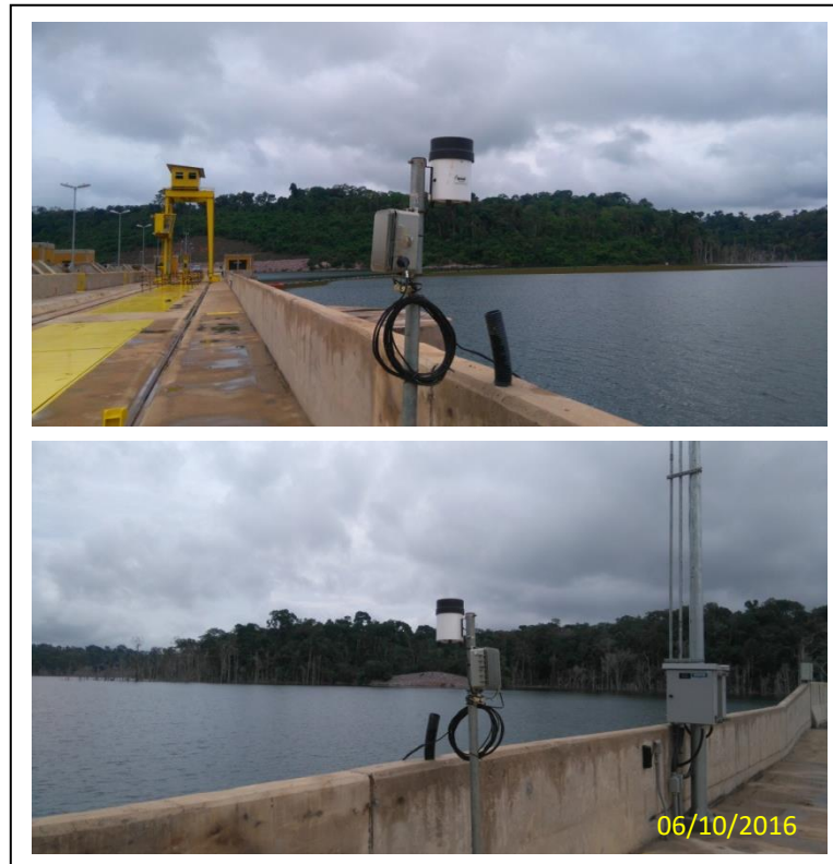
Figura 35. Estação hidrométrica UHE Teles Pires Barramento durante vistoria realizada no dia 06 de outubro de 2016.
