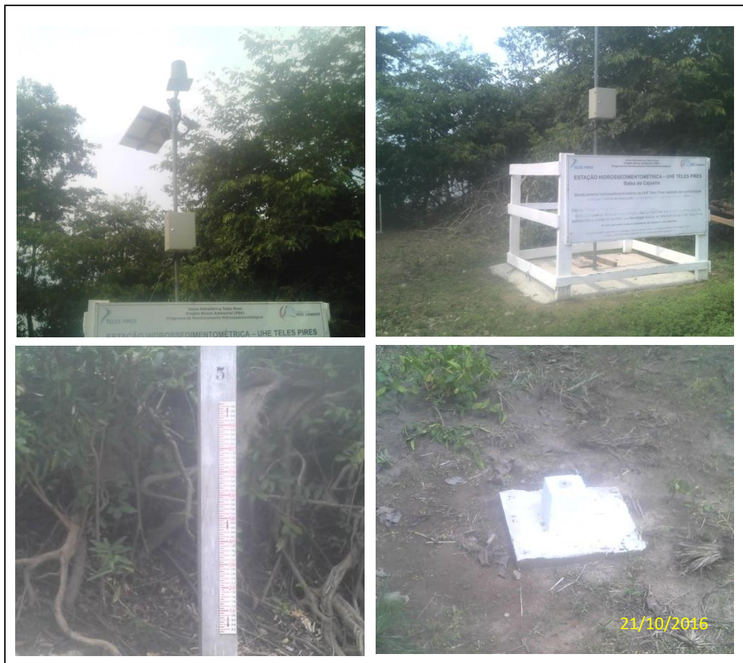
Figura 32. Estação hidrométrica UHE Teles Pires Montante 2 durante vistoria realizada no dia 21 de outubro de 2016.
