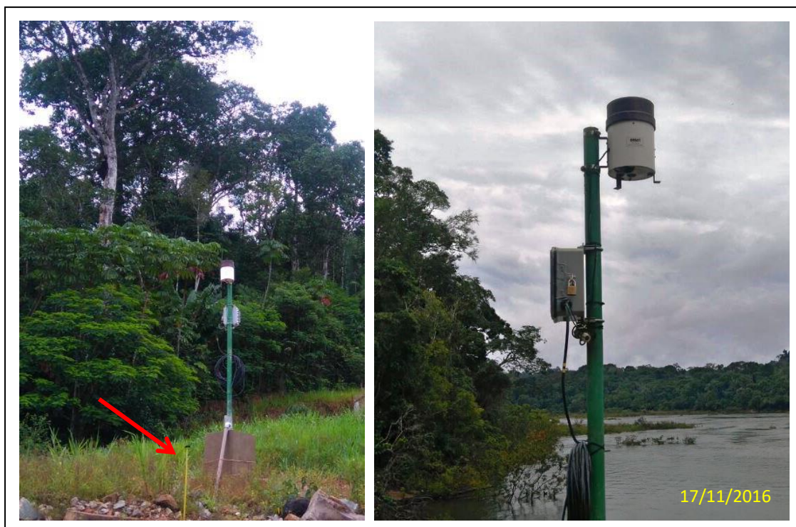
Figura 26. Estação hidrométrica UHE Teles Pires Jusante durante vistoria realizada no dia 17 de novembro de 2016. A seta em vermelho indica a estaca instalada próxima a estação para o monitoramento da margem do local.
