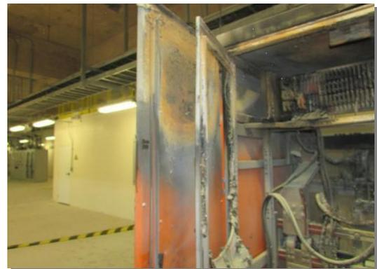
**Figura 22/23.** Registro após foco de incêndio no painel de excitação CEX U2 ocorrido no dia 20/09/2016.
