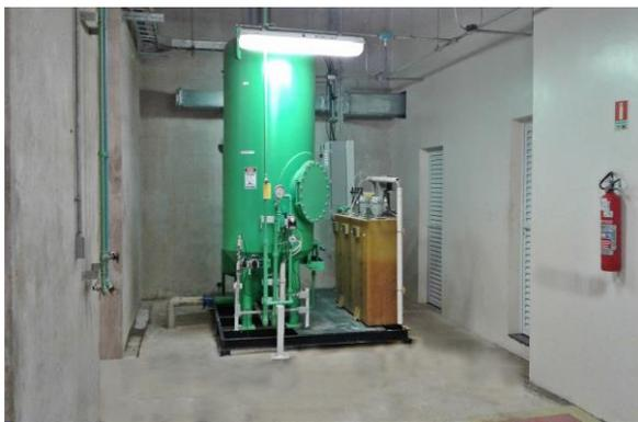
**Figura 02.** ETA – Casa de Força UHE Teles Pires.
