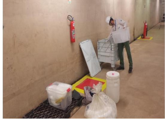
**Figuras 10/11.** Atendimento emergencial a derramamento de óleo com aplicação de manta e pó absorvente de óleo.
