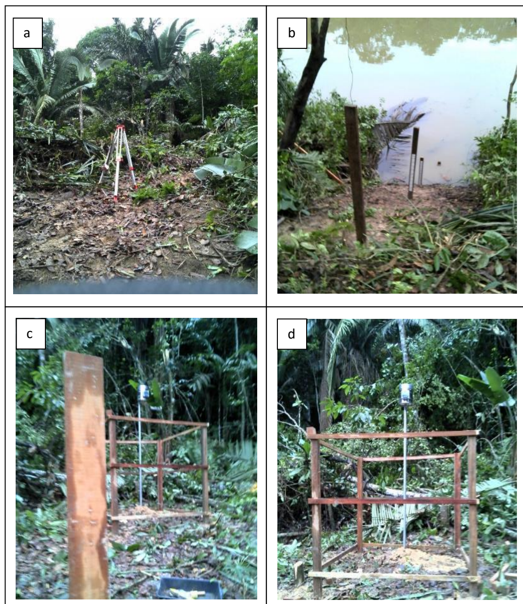
Figura 2. Instalação da estação hidrométrica Coelho. (a) limpeza do local e nivelamento das réguas com o nível topográfico; (b) réguas limnimétricas; (c) e (d) pluviógrafo e cercado com esteios de madeira.
