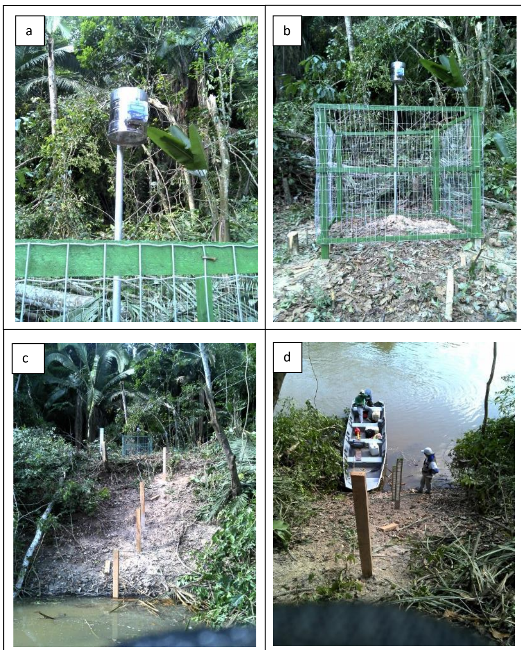
Figura 3. Instalação da estação hidrométrica Apiácas. (a) pluviógrafo; (b) cercado com esteios de madeira, tela de aço galvanizado e pintura; (c) e (d) réguas limnimétricas.
