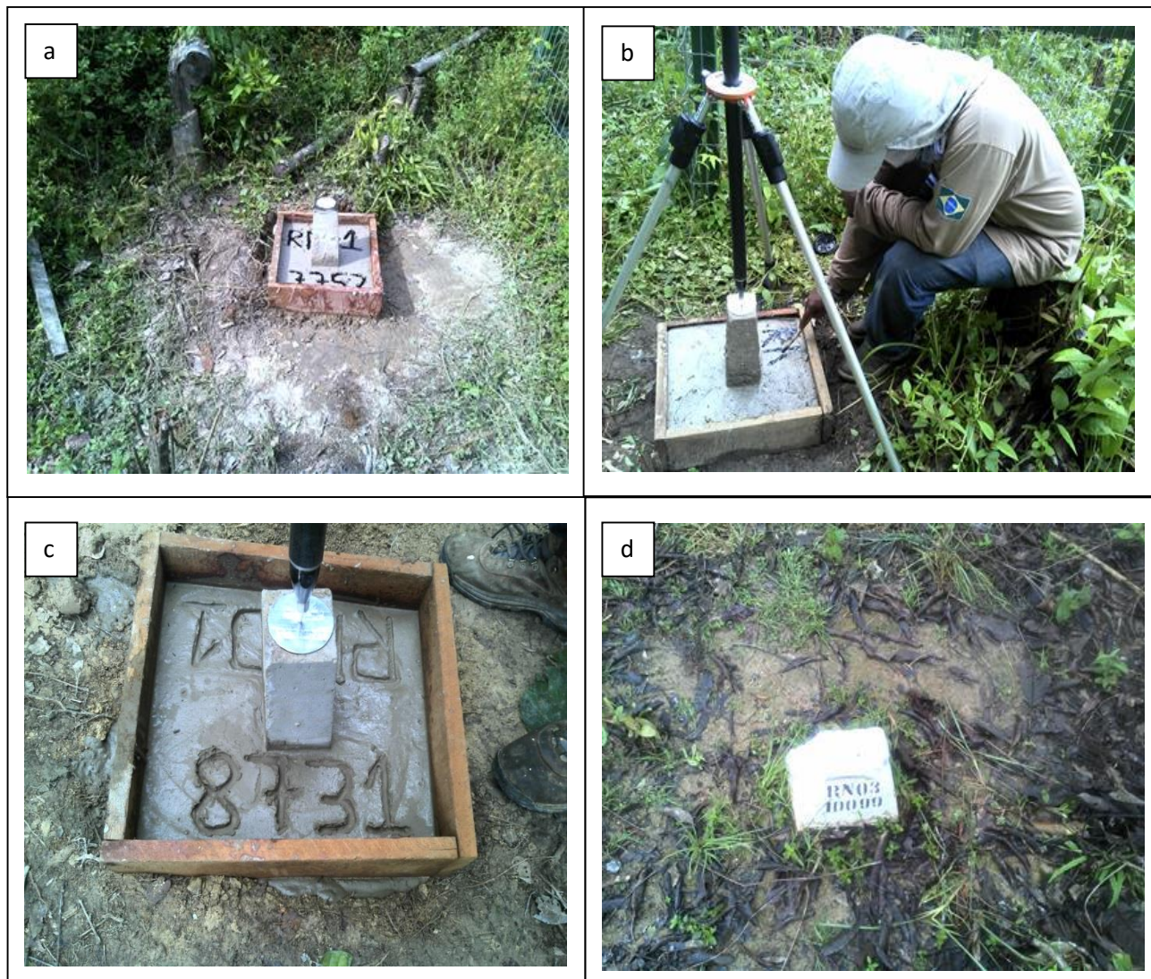
Figura 7. Instalação das referências de nível (RN's) das estações hidrométricas. (a) RN da estação São Benedito; (b) estação Coelho; (c) estação Apiácas, (d) na estação Santa Rosa foi aproveitado o RN instalado pela ANA.
