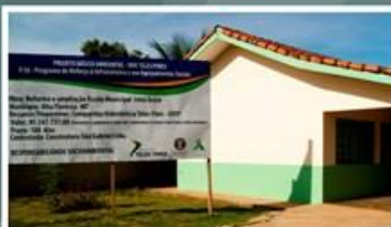
Reforma e ampliação de 11 escolas municipais
