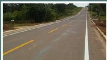
Pavimentação asfáltica e drenagem da Av. Perimetral Teles Pires
