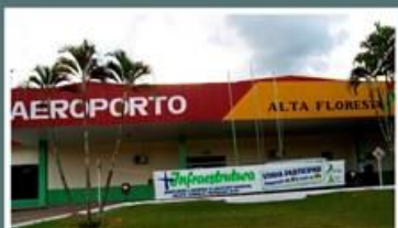
Ampliação e reforma do aeroporto de Alta Floresta
