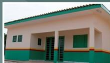
Construção de 2 novos postos de atendimento social
