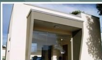
Construção do Laboratório de Hematologia de Alta Floresta
