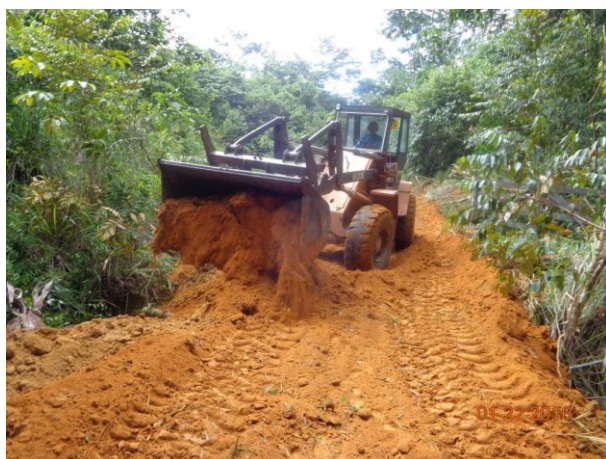
Foto 105. Manutenção de acessos.
