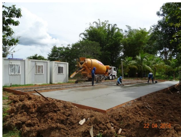
Foto 168. Construção do piso para instalação dos contêineres. Parceria CHTP X OURO VERDE
