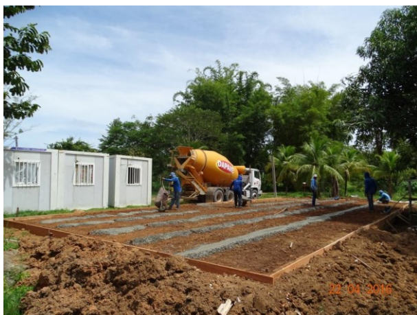
Foto 167. Construção do piso para instalação dos contêineres. Parceria CHTP X OURO VERDE
