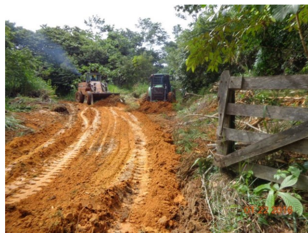
Foto 106. Manutenção de acessos.
