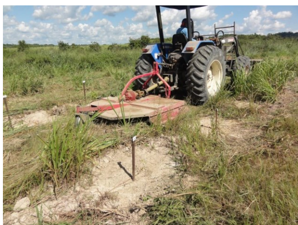
Foto 147. Roçada mecanizada.
