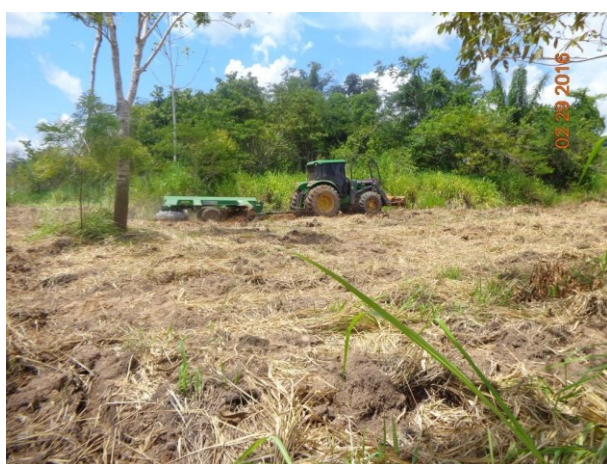
Foto 9. Preparo de solo mecanizado para o plantio em ilhas.
