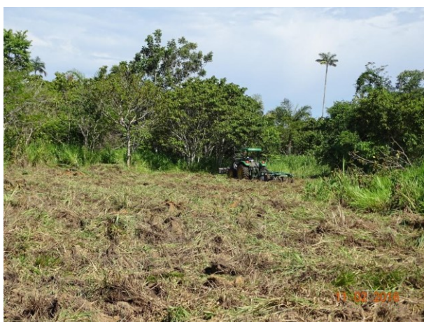
Foto 15. Preparo de solo mecanizado para o plantio em ilhas.
