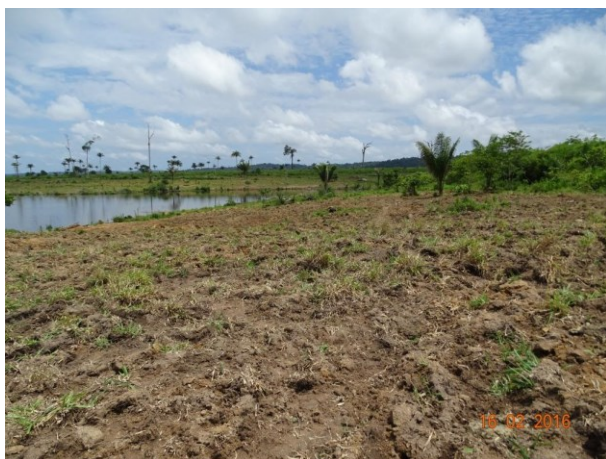
Foto 17. Preparo de solo mecanizado para o plantio em ilhas.
