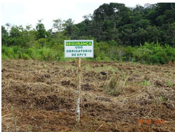
Foto 135. Instalação de placas de identificação, alertando para o uso de EPI's.
