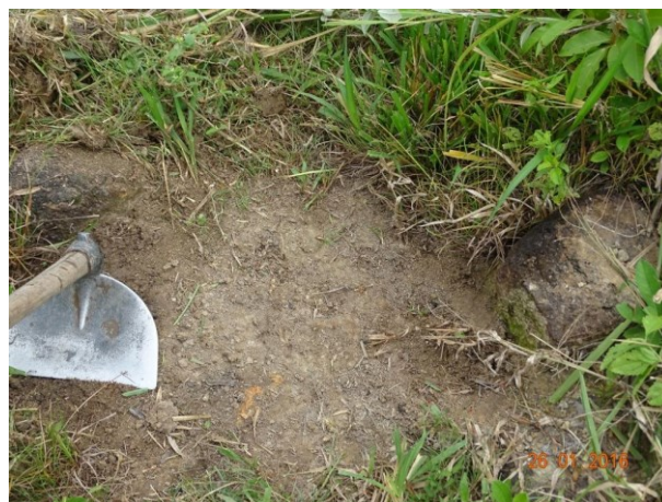
Foto 72. Preparo de solo manual.
