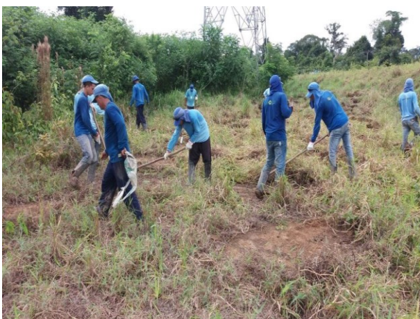
Foto 3. Equipe realizou o coroamento e abertura de covas nas cabeceiras das pontes para realizar o plantio.
