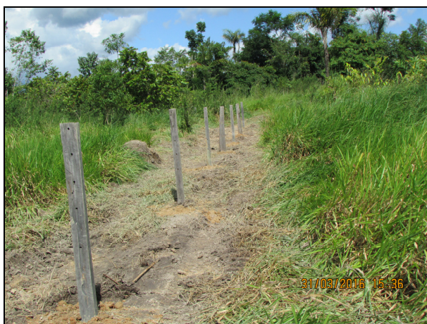
Foto 03. Construção de cercas na UHETP 10.
