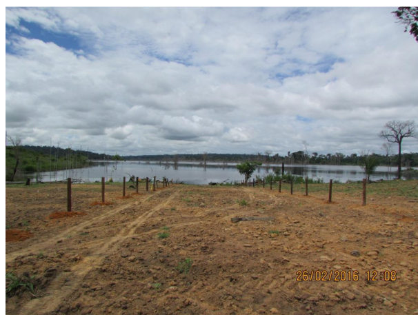
Foto 06. Construção de corredores de dessedentação animal.
