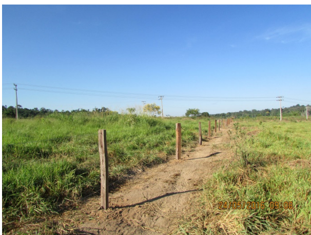
Foto 01. Construção de cercas.
