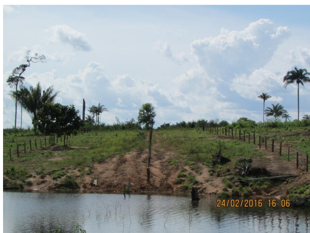
Foto 07. Construção de corredores de dessedentação animal.
