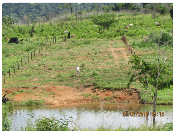
Foto 08. Construção de corredores de dessedentação animal.
