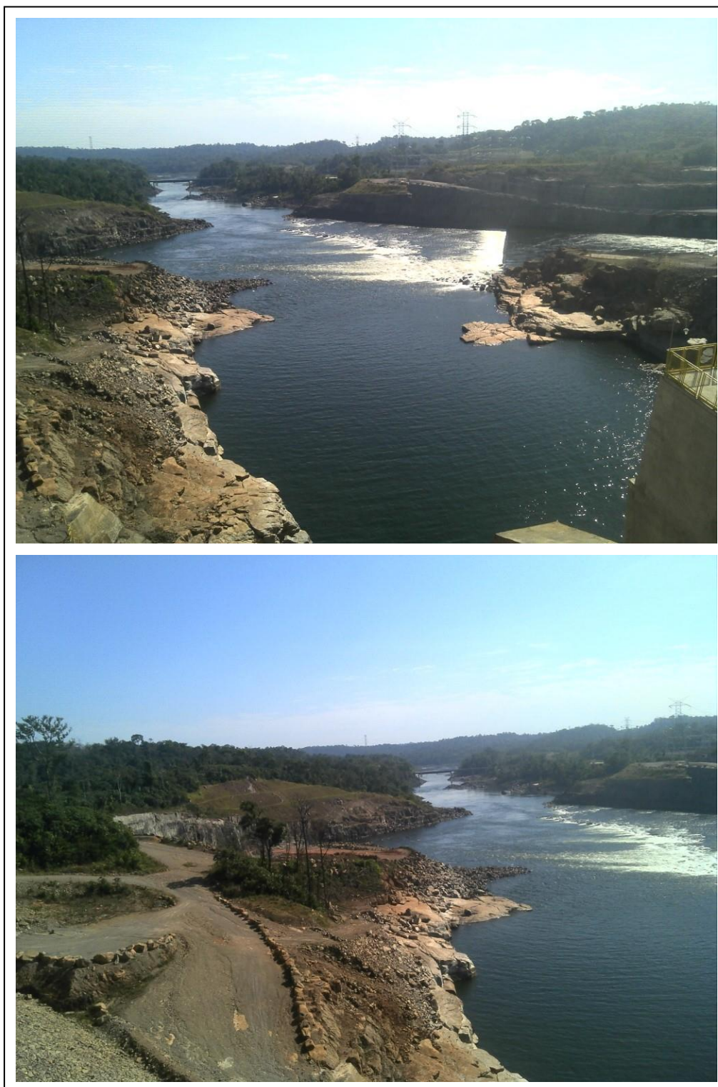
Figura 16. Vista da porção imediatamente a jusante da barragem da UHE Teles Pires. Os afloramentos rochosos e enrocamentos inseridos proporcionam estabilidade ao local.
