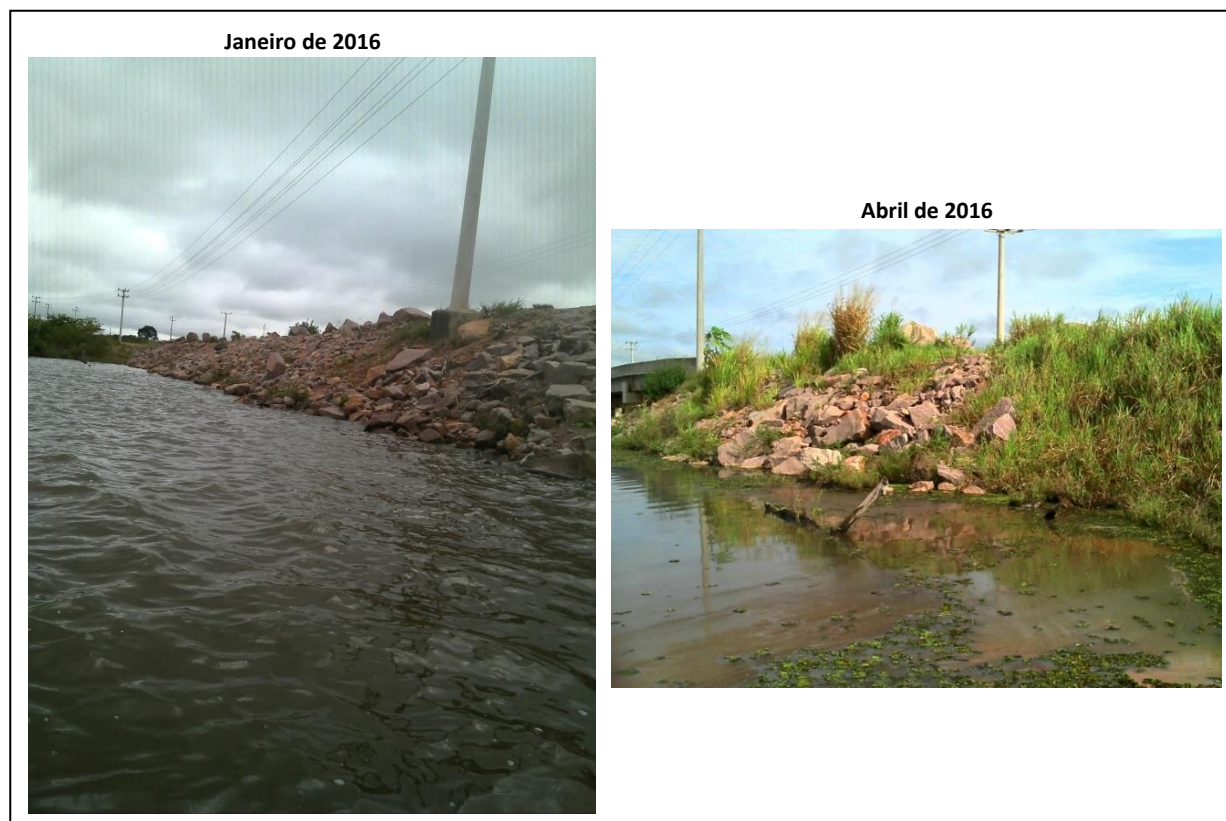
Figura 21. Ponto MD-23, localizado na nova ponte do rio Paranaíba.
