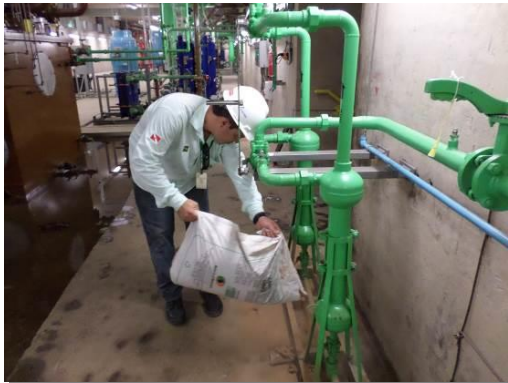
Figuras 10/11. Atendimento emergencial a derramamento de óleo com aplicação de manta e pó absorvente de óleo.
