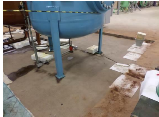
Figuras 10/11. Atendimento emergencial a derramamento de óleo com aplicação de manta e pó absorvente de óleo.
