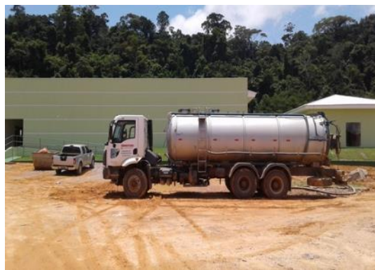
Figura 03. Coleta de efluentes na área do alojamento.
