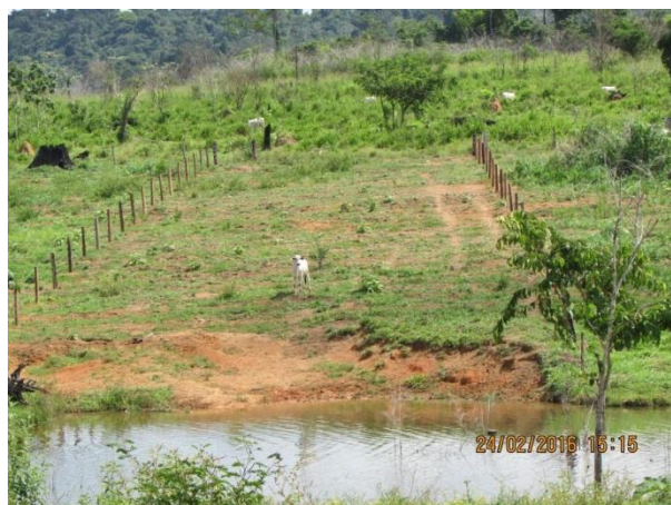
Foto 08. Construção de corredores de dessedentação animal.
