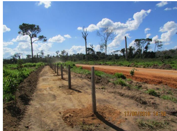
Foto 06. Construção de cercas.
