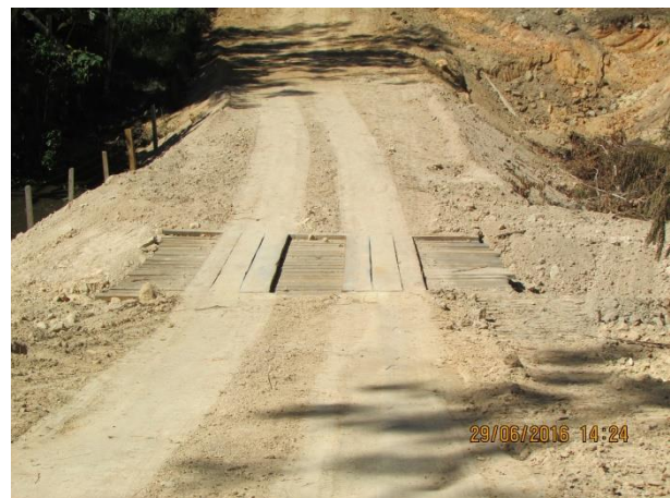
Foto 04. Construção e reforma de pontes.
