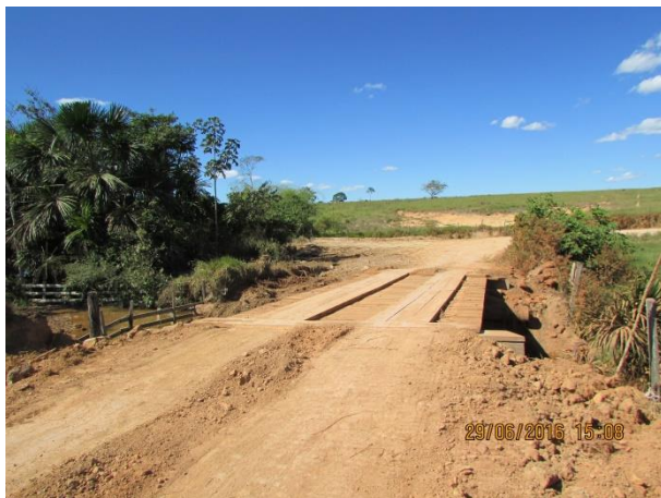
Foto 01. Construção e reforma de pontes.
