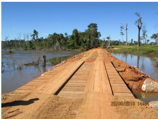
Foto 03. Construção e reforma de pontes.
