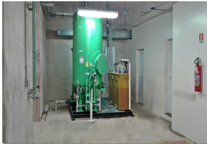
Figura 01 - ETA – Casa de Força UHE Teles Pires.
