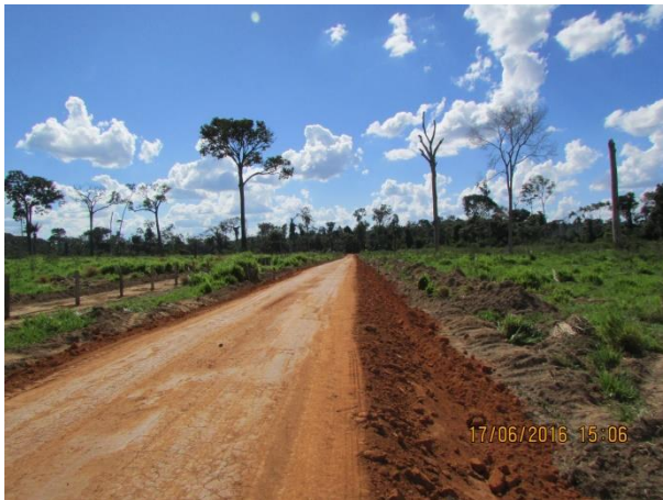
Foto 05. Cascalhamento e patrolamento de acessos.
