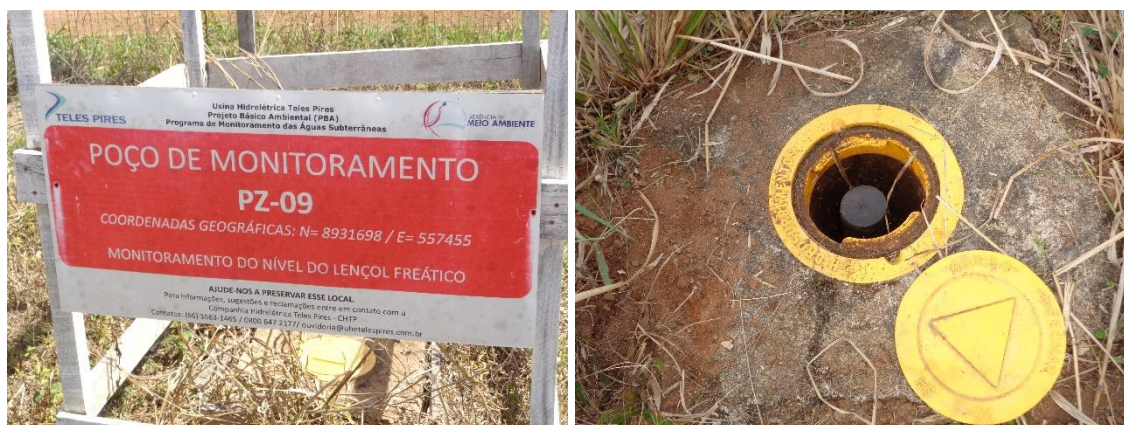
Figura 02. Pontos de amostragem dos Piezométricos na área de influência da UHE Teles Pires.
