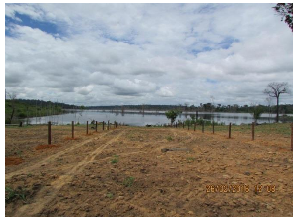
Foto 06. Construção de corredores de dessedentação animal.
