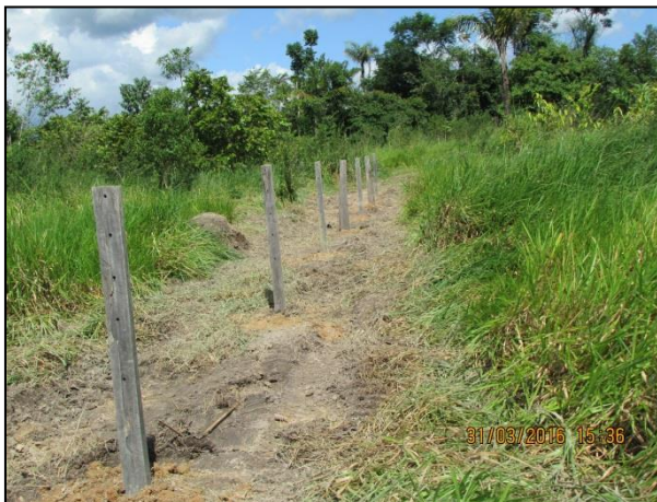
Foto 03. Construção de cercas na UHETP 10.
