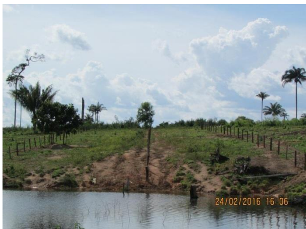
Foto 07. Construção de corredores de dessedentação animal.
