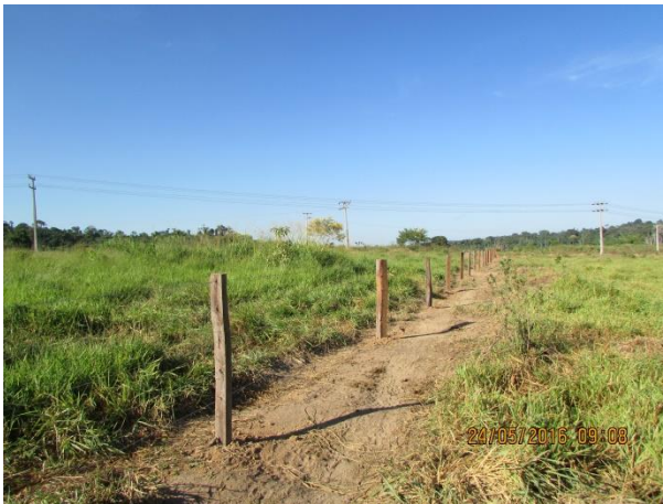
Foto 01. Construção de cercas.
