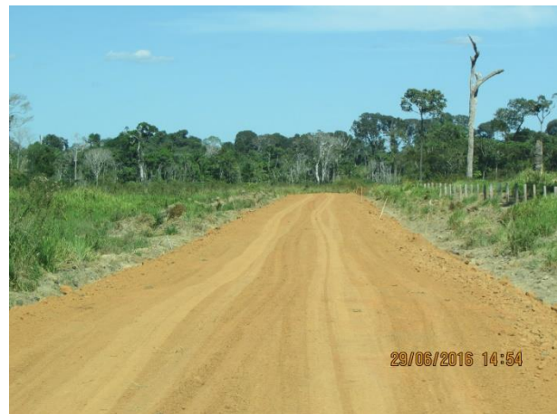
Foto 02. Cascalhamento e patrolamento de acessos.
