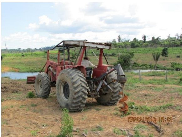
Foto 05. Perfuração mecanizada para construção das cercas.
