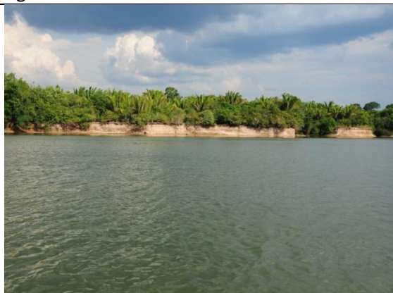
Figura 155. Margem em barranco.
