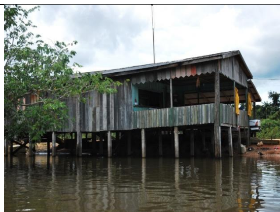
Figura 6. Moradia suspensa a margem do rio.
