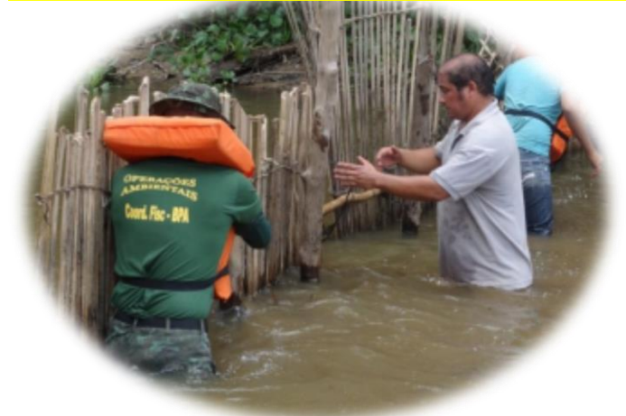
Tapagem com estacas de madeira
